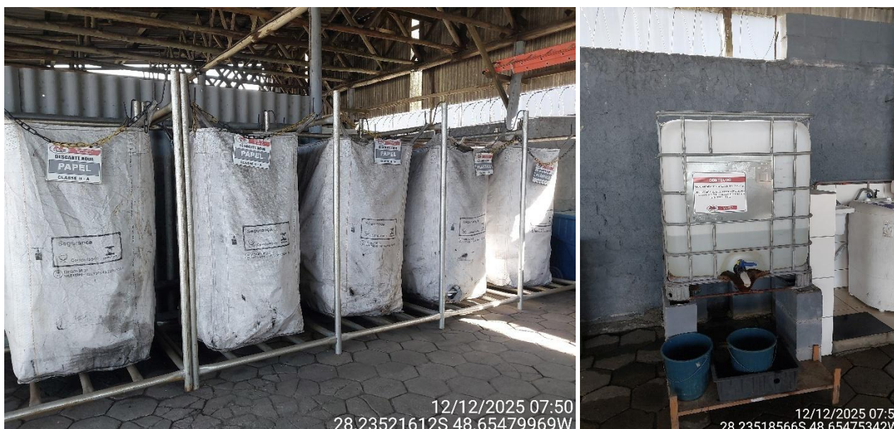
Figura 9 Central de Resíduos
