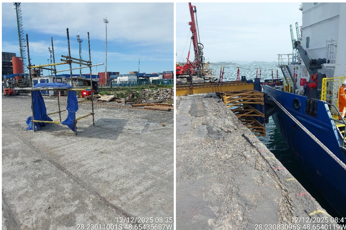
Figura 7 Cais 3 – Obra de Revitalização em Progresso
