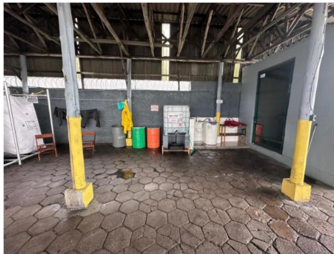
Vista Interna – Central de resíduos
