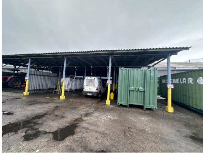
Visão Geral da Central de Resíduos
