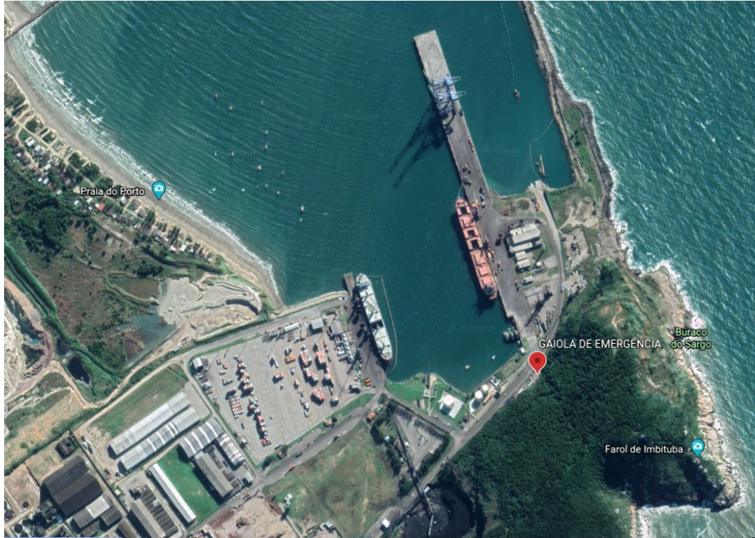
Figura 13 – Localização da gaiola de emergência
