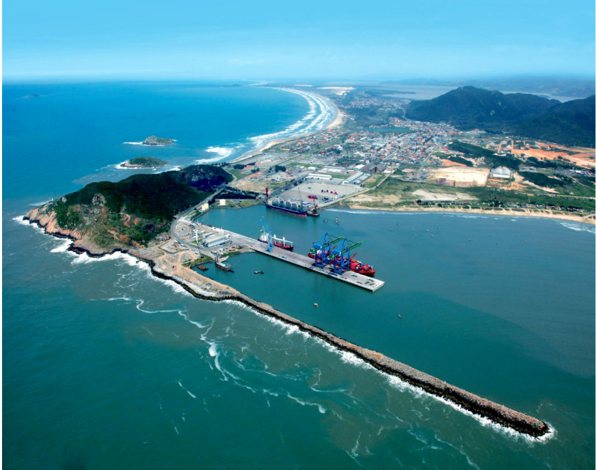
Figura 5 – Imagem aérea do Porto de Imbituba
