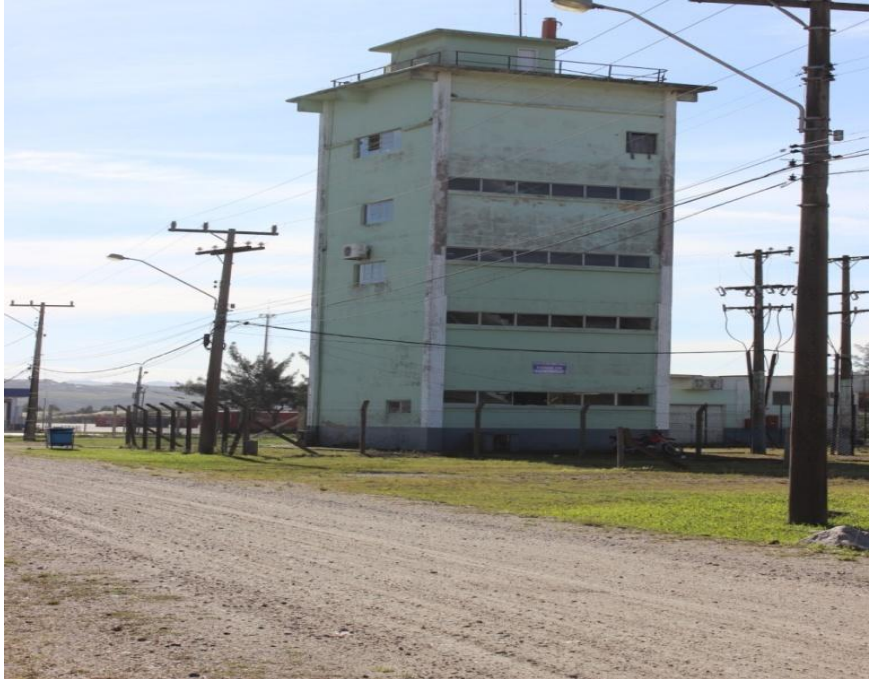
Torre de Monitoramento Fonte: Autores (2017)
