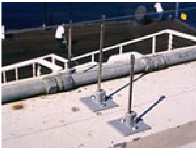
Figura 6. Sistema de arames do tipo post and wire stick on base .
