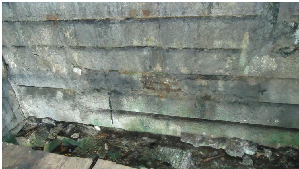
Figura 12 - Obra de contenção objetivando estabilizar a estrutura do aterro
