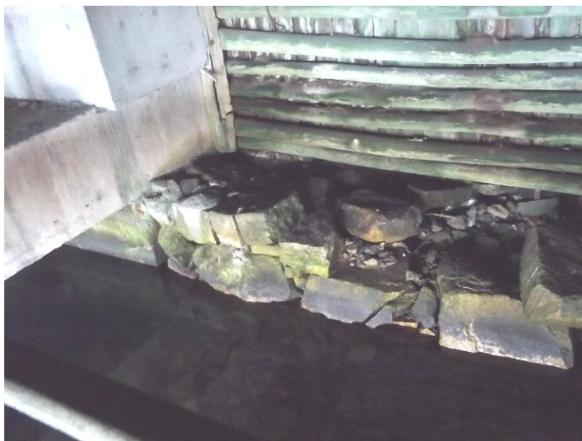
Figura 10 - Estrutura de contenção sobre o enrocamento
