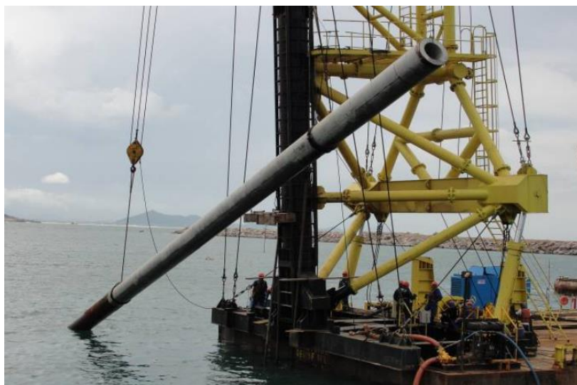
Figura 3 - Içamento da estaca
