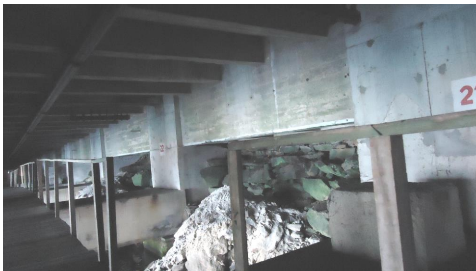
Figura 13 - Tentativa de estabilização da base do enrocamento
