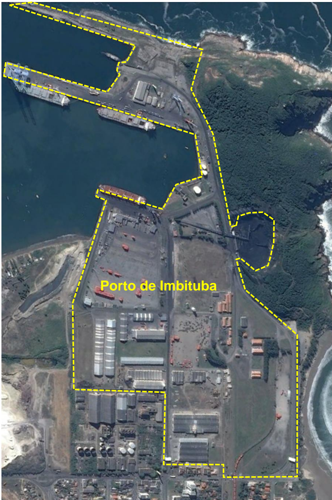
Figura 21. Imagem aérea do Porto de Imbituba (Data: 09/06/2016). Fonte: Google Earth (2016)
