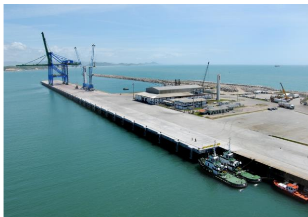
Figura 6- Entrega da obra em 2011
