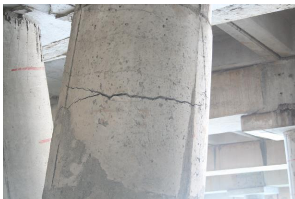
Figura 10- Estacas rompidas devido ao recebimento de carga.
