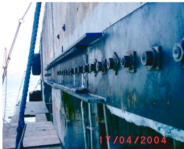
Figura 3 - Obra de reforço Cais 1
