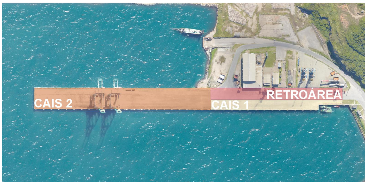
Figura 9- Localização da área a ser prestado o serviço.
