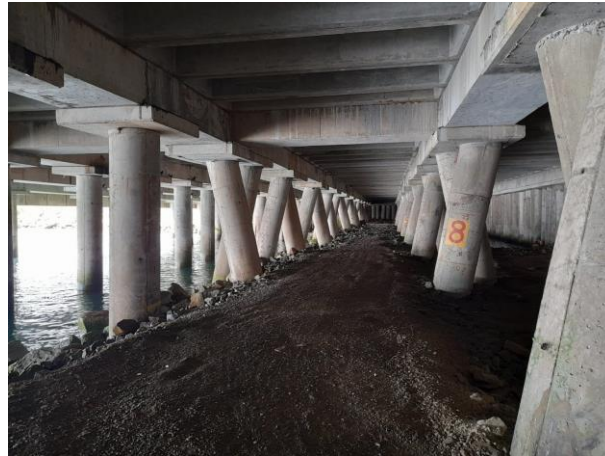
Figura 12- Visão inferior do Cais 2.
