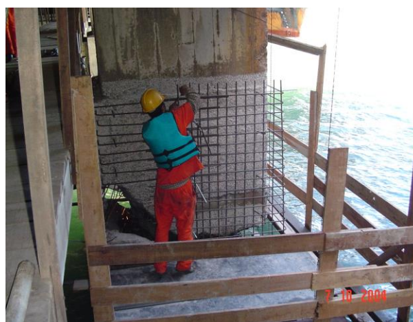
Figura 5 - Reforço em elementos estruturais Cais 1 em 2004
