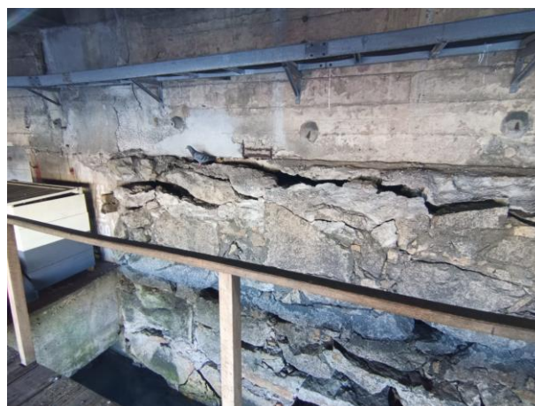
Figura 14- Muro de pedras início cais 1.
