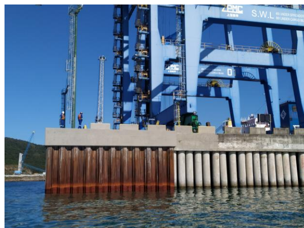
Figura 7- Obra finalizada em 2021
