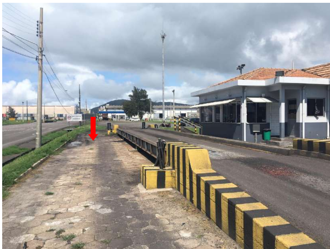
Figura 04 – Local da instalação da plataforma (Balança 2)
