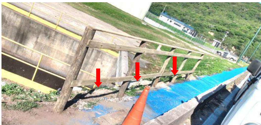
Figura 06 – Local da instalação dos guarda-corpos (Caminho seguro – VL6)
