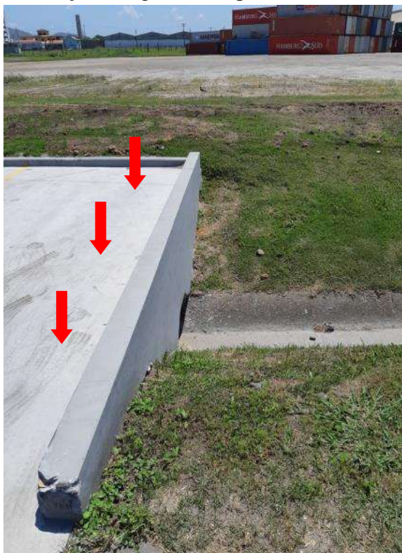
Figura 05 – Local da instalação dos guarda-corpos (Estacionamento interno Portaria 1)
