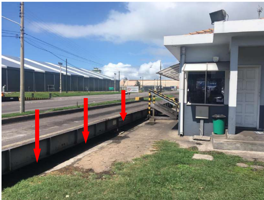
Figura 03 – Local da instalação da plataforma com escada (Balança 2)
