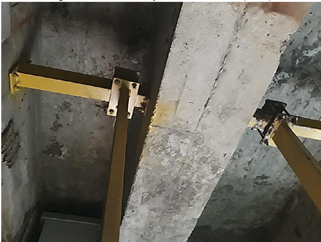
Figura 15 – Sistema de fixação da escada existente (Cais 1)
