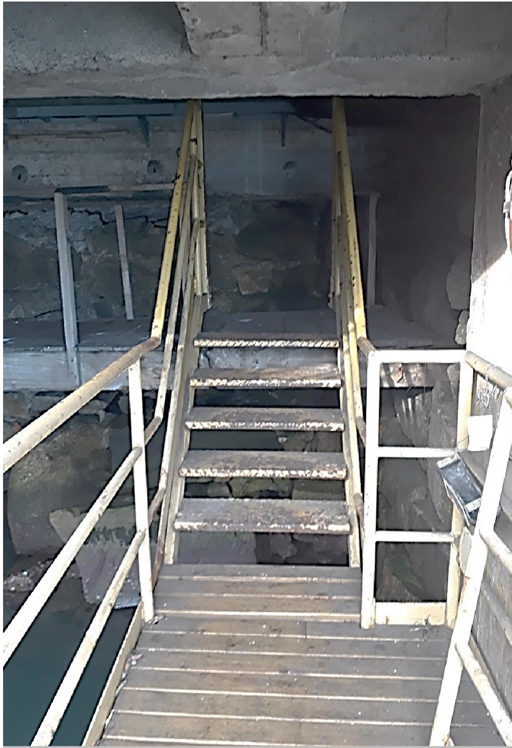
Figura 16 – Sistema de fixação da escada existente
