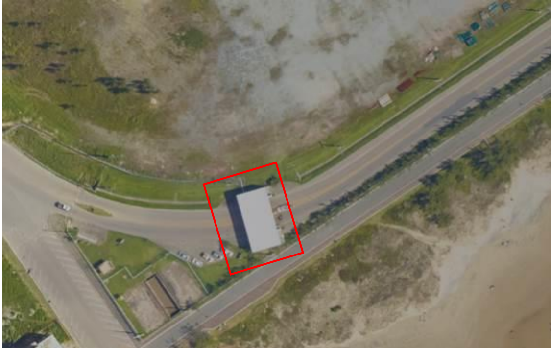
Figura 08 – Localização da edificação
