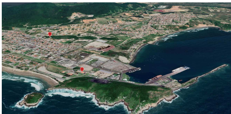
Figura 12 – Local de entrega Porto de Imbituba – SCPAR - (28°14'08"S; 48°39'23"W)
