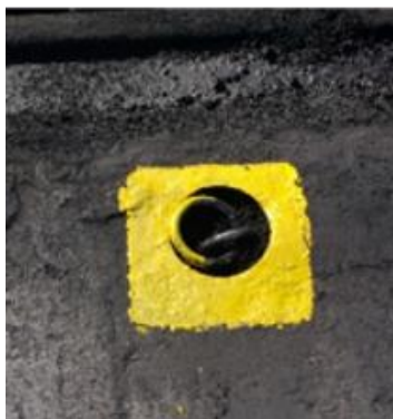
Figuras 03, 04 e 05 – Exemplos de ganchos em inox instalados nos cais
