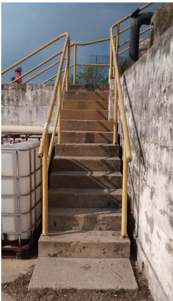
Figura 5 – Escada a ser substituída (Escada 3)
