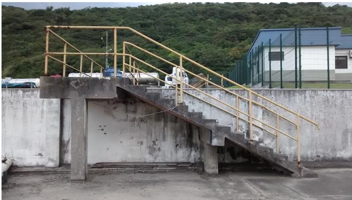
Figura 2 – Local da instalação dos guarda-corpos (Escada 1)
