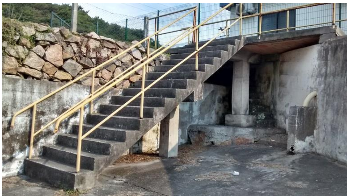
Figura 4 – Local da instalação dos guarda-corpos (Escada 2)
