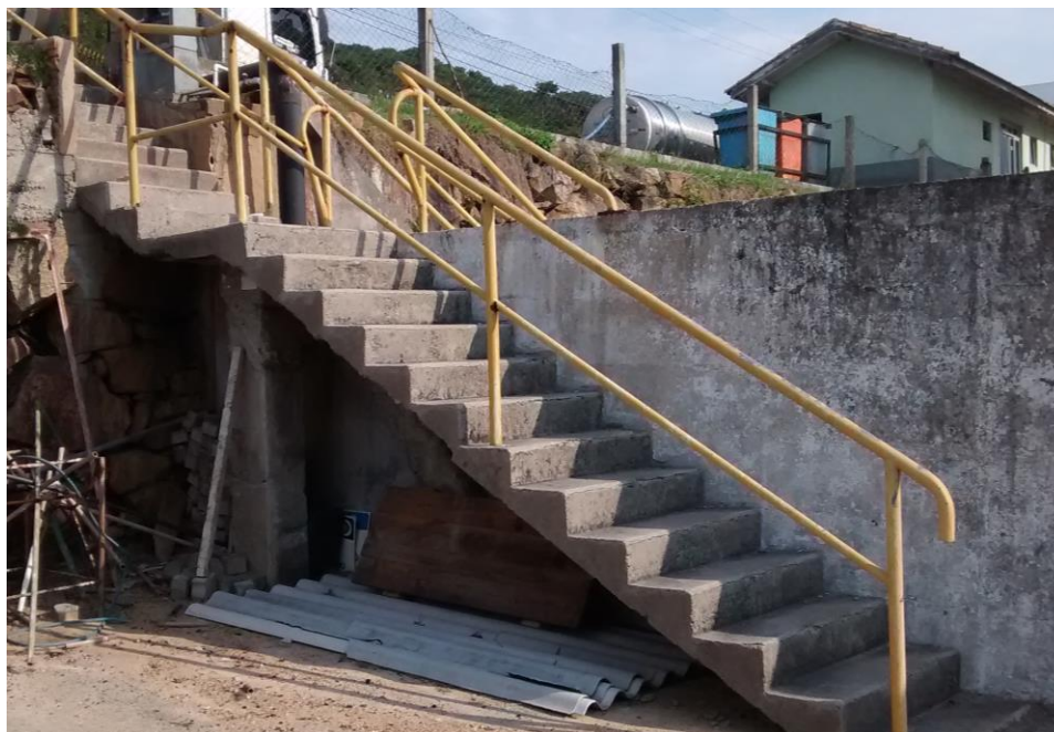
Figura 6 – Escada a ser substituída (Escada 3)
