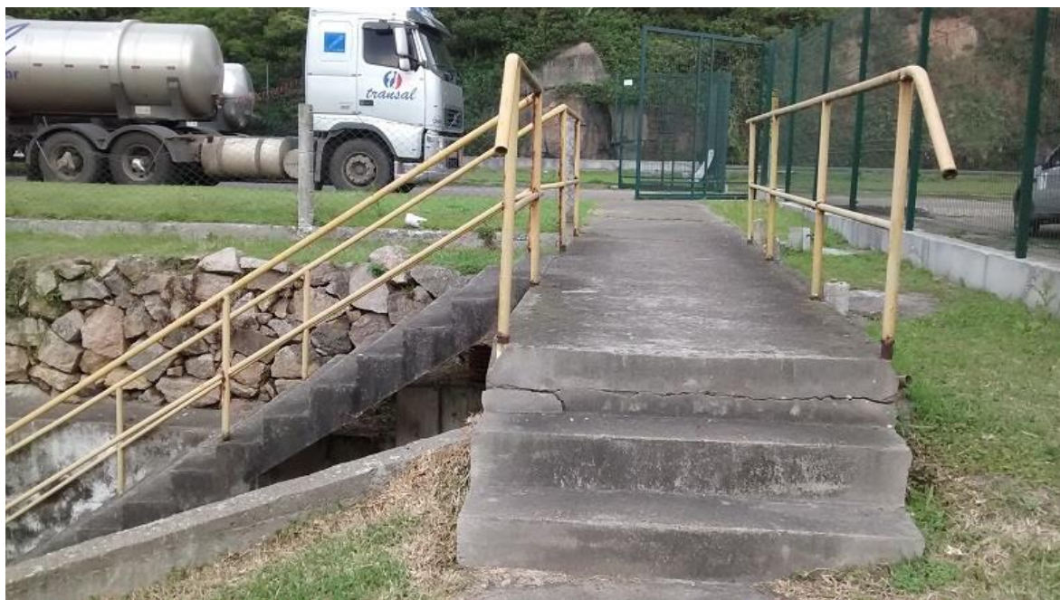
Figura 3 – Local da instalação dos guarda-corpos (Escada 2)
