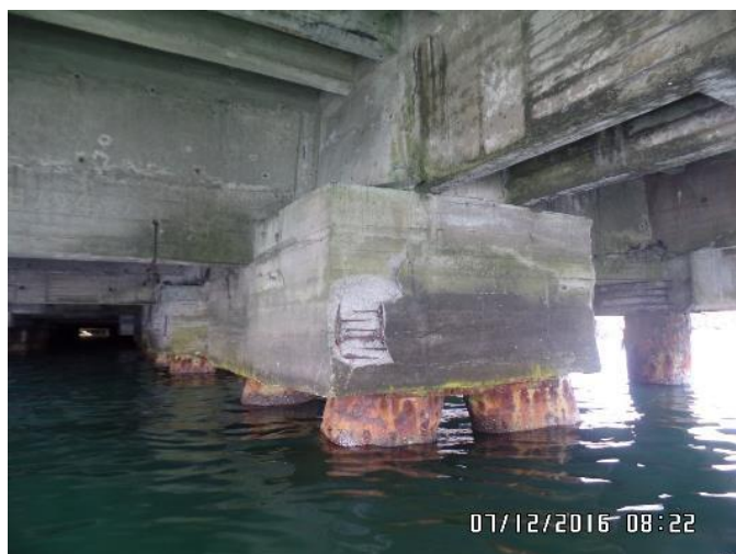
Figura 05 – Estrutura do Cais 03
