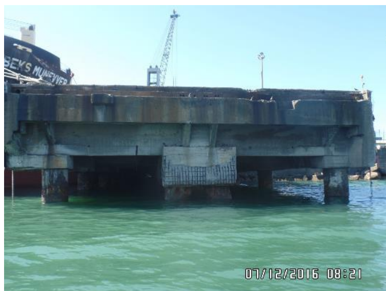
Figura 01 – Estrutura do Cais 03
