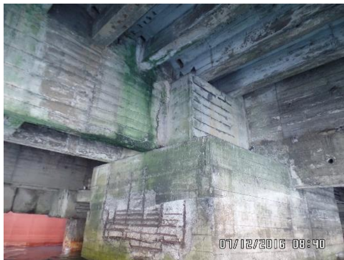
Figura 07 – Estrutura do Cais 03
