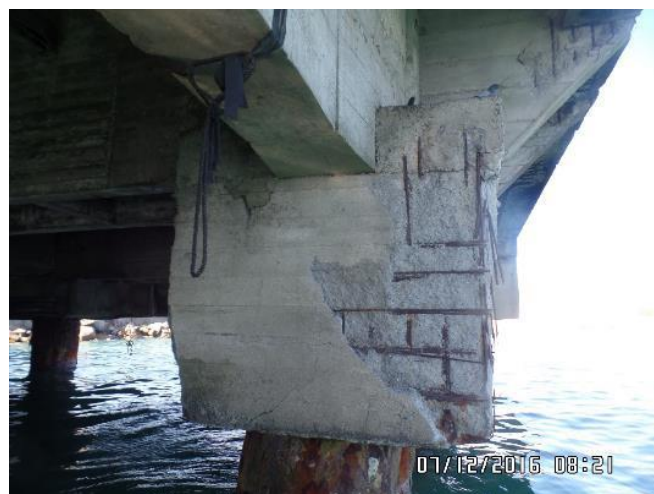
Figura 03 – Estrutura do Cais 03
