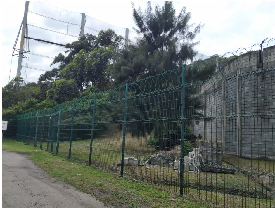
Figura 10 – Modelo de instalação de Concertina com espera
