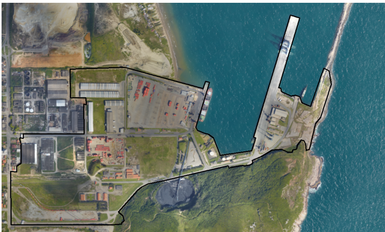
Figura 12 – Área para execução de cercamento
