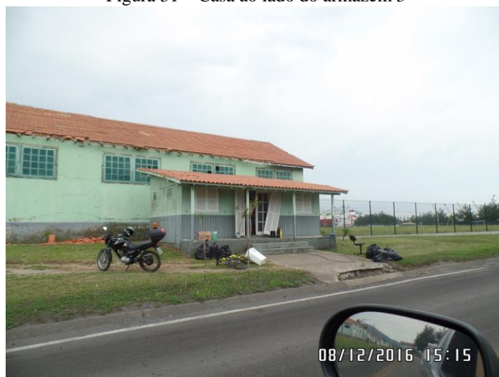
Figura 31 – Casa ao lado do armazém 3
