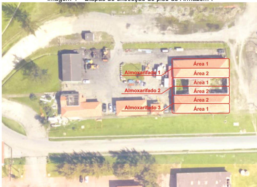
Imagem 4 – Etapas de execução do piso do Armazém 7
