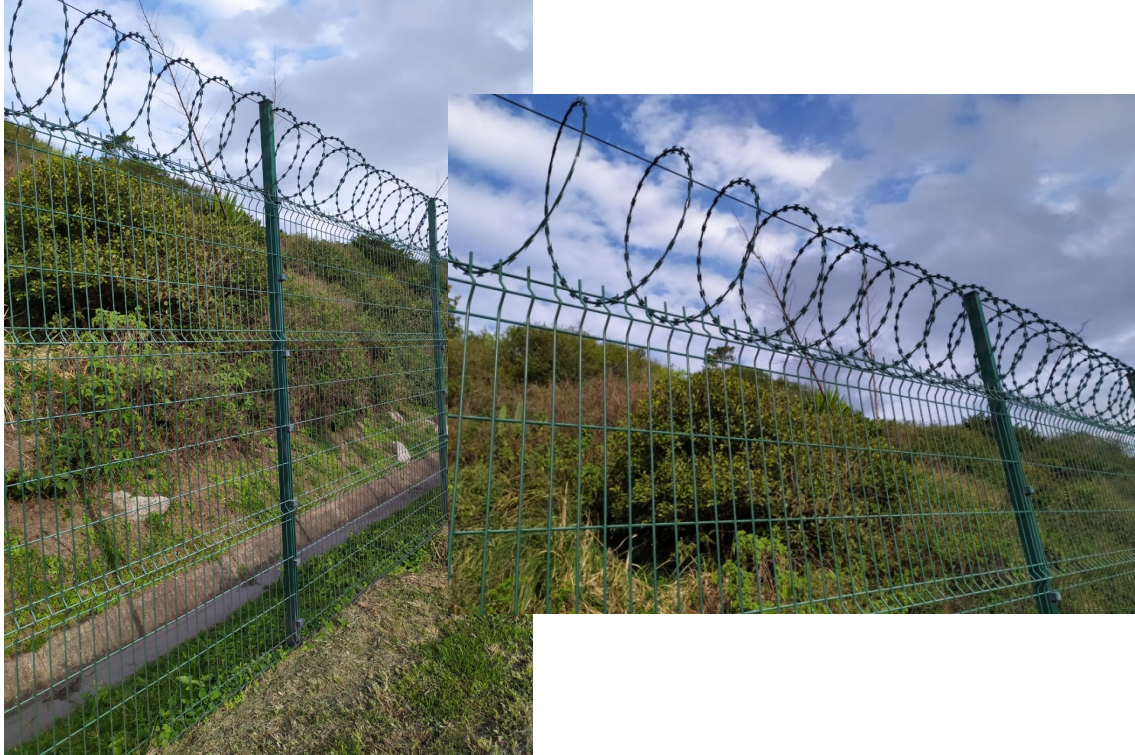
Figura 01 – Concertinas instaladas na SCPAR Porto de Imbituba (Foto: acervo)
