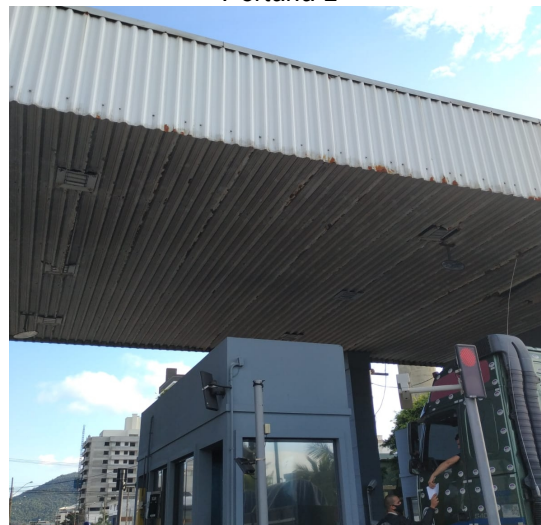
Figura 3: Foto inferior da Cobertura Metálica da Portaria 2
