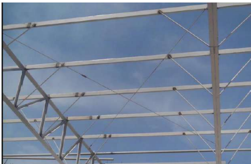
Figura 7 – Contraventamento de estrutura metálica
