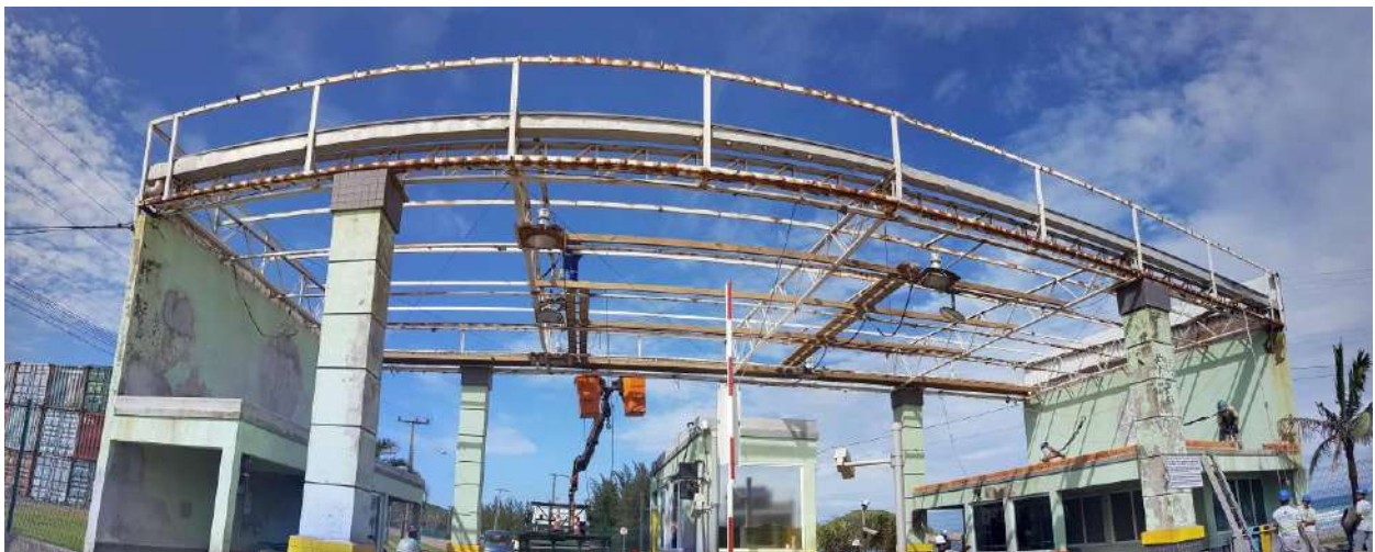
Figura 9 – Vista da estrutura pela entrada da Portaria 1 em março/2020.
