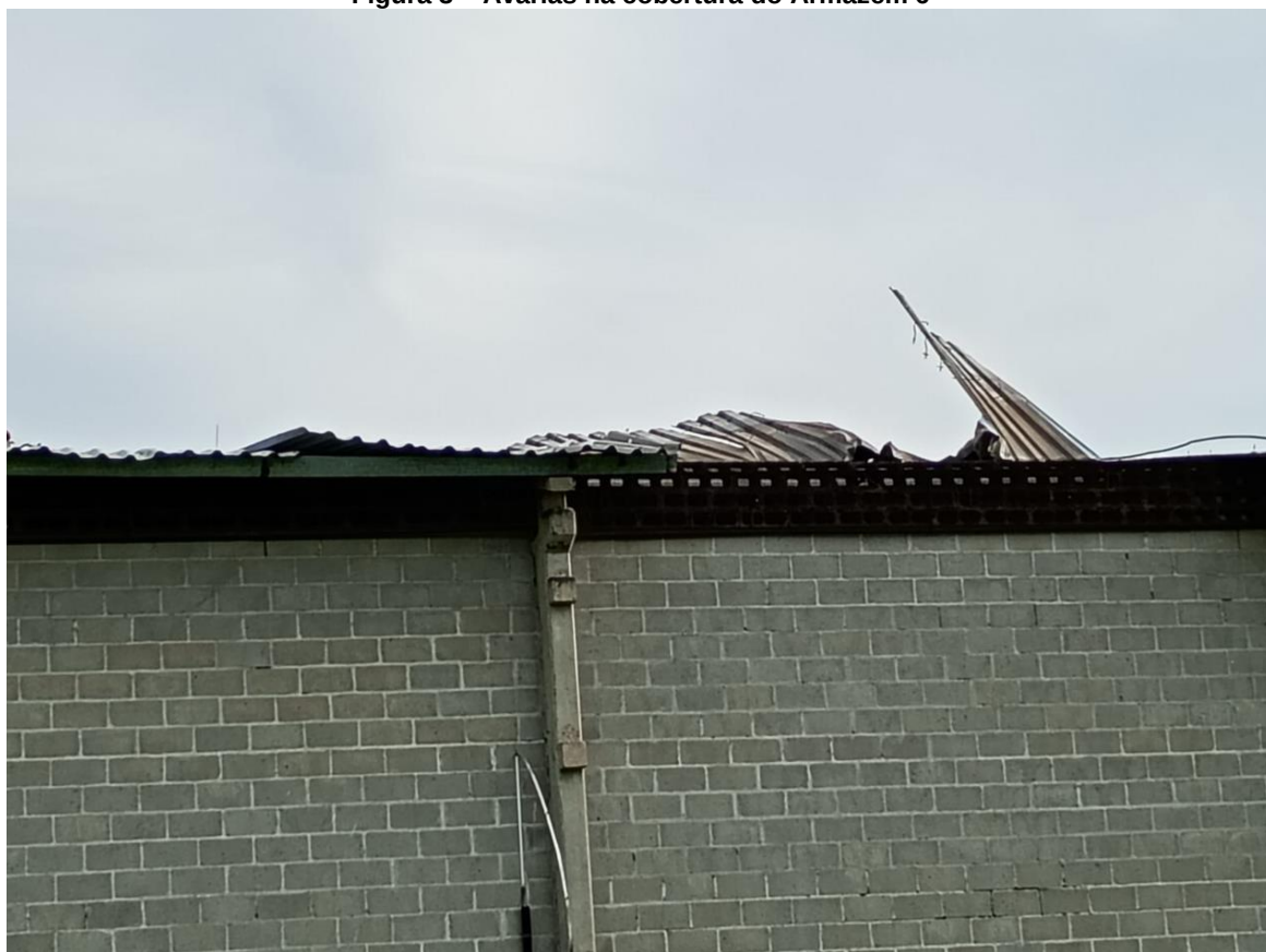
Figura 4 – Avarias na cobertura do Armazém 6
