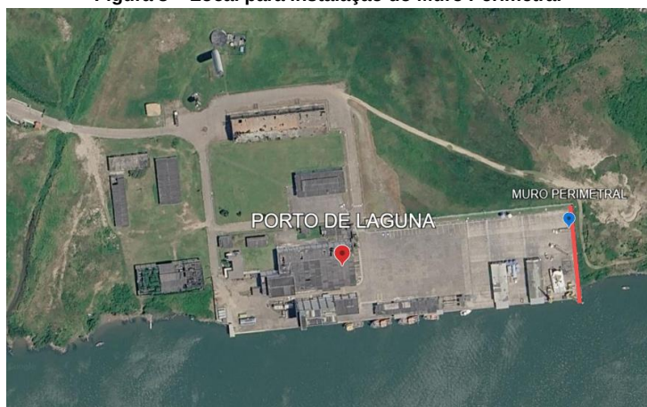
Figura 8 – Local para instalação do Muro Perimetral
