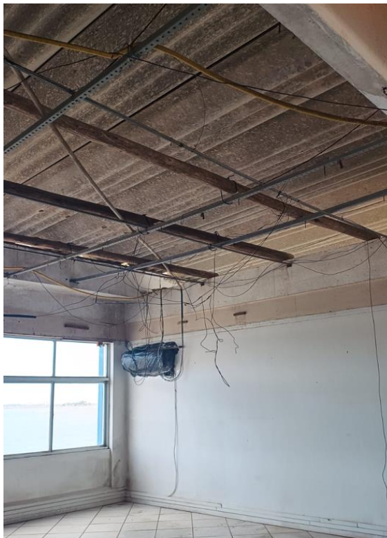
Figura 9 – Local para instalação do Forro PVC
