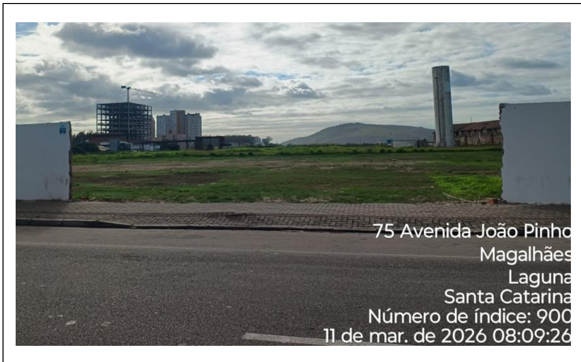
Figura 7: Vista da avenida, imagem externa abertura 02.
