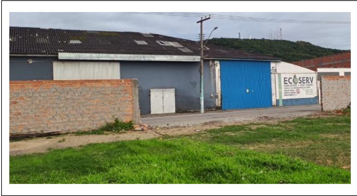
Figura 4: Retro área, imagem interna abertura 02.
