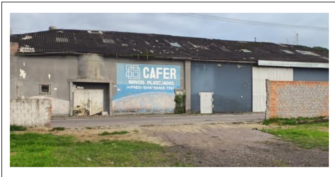
Figura 3: Retro área, imagem interna abertura 01.
