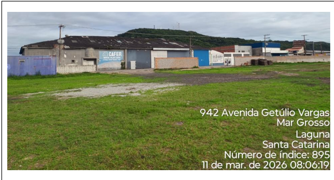
Figura 2: Retro área, imagem interna duas aberturas.
