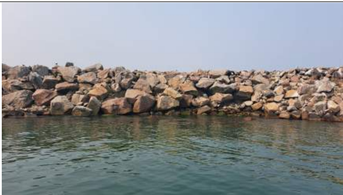
Estrutura do molhe lado Oeste.
