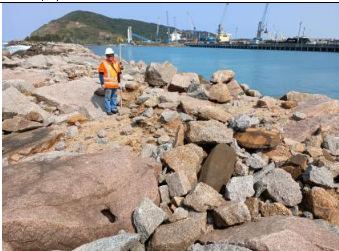
Enrocamento, seção - mesmo ponto, com vista para sul e com vista para oeste.
