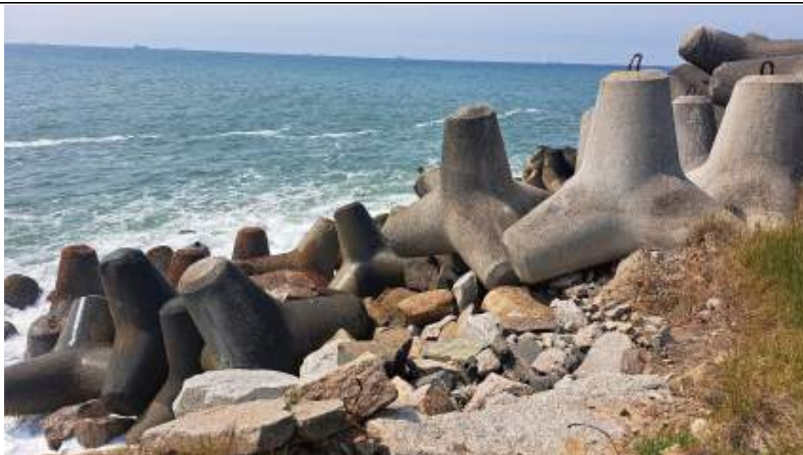
Tetrapodes, seção 31 - limite da área dos tetrápodes, molhe lado leste. Mostra a degradação provocada pela erosão.
