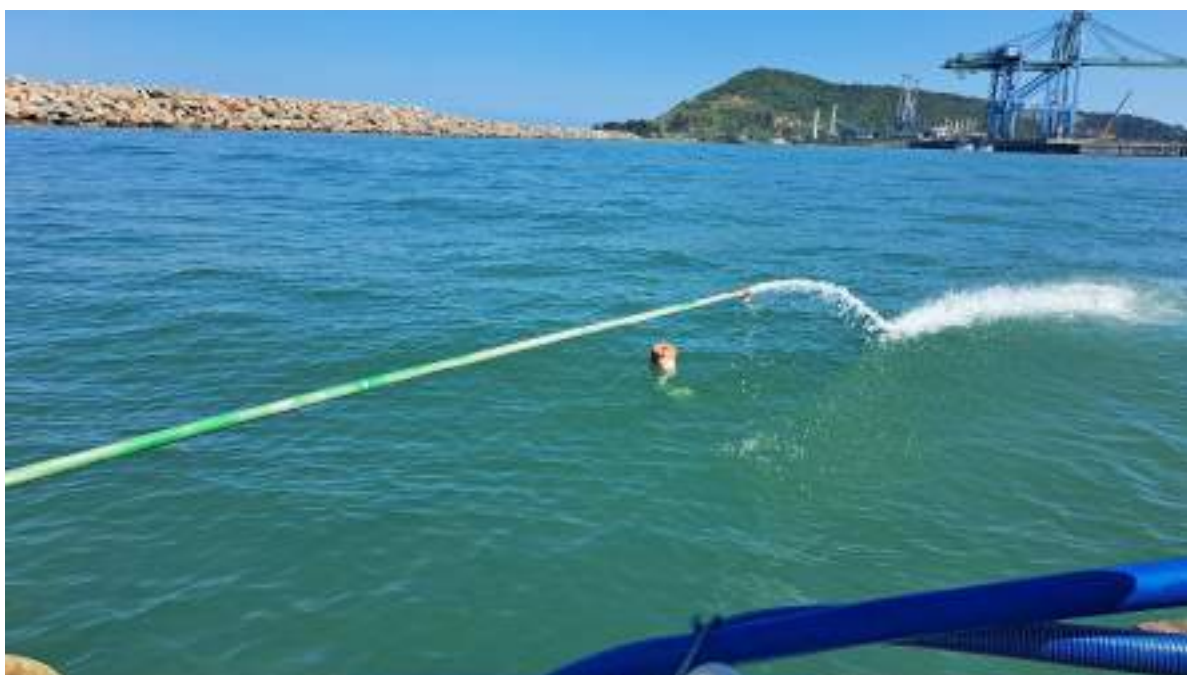
Figura 102 – Jato d'água que proporciona o avanço da haste nos sedimentos.
