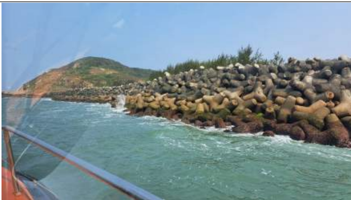
Estrutura do molhe lado Leste.
