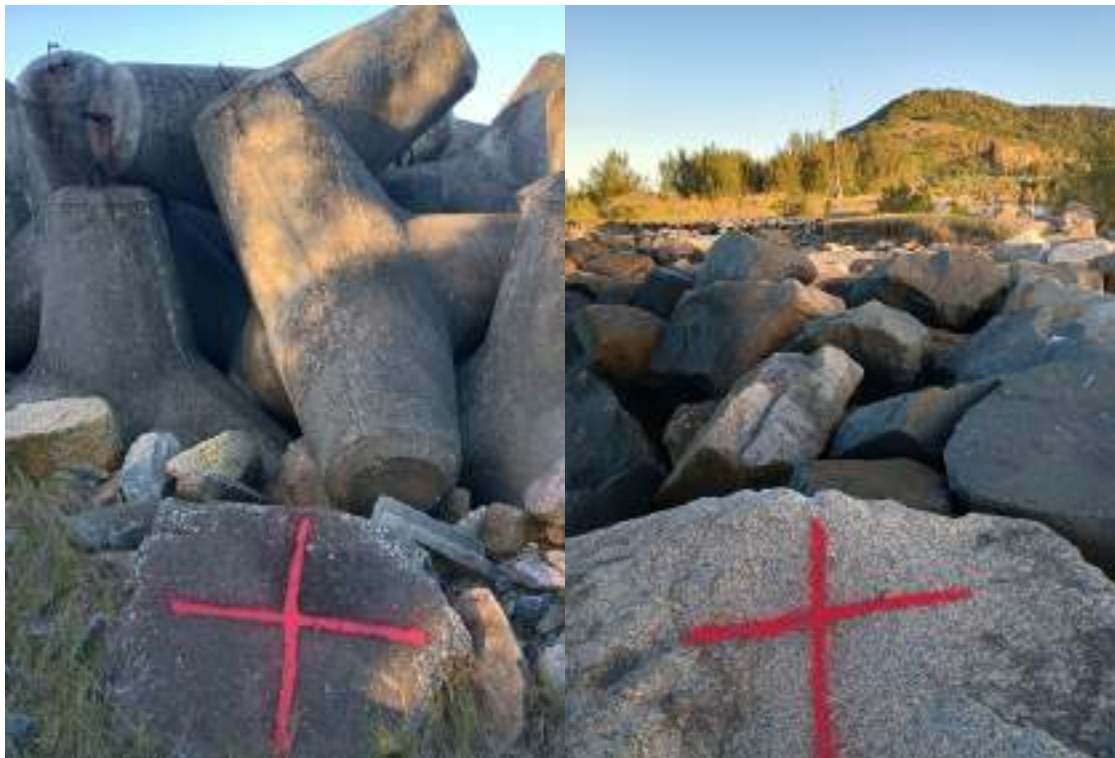
Figura 82 – Implantação dos pontos de controle.
