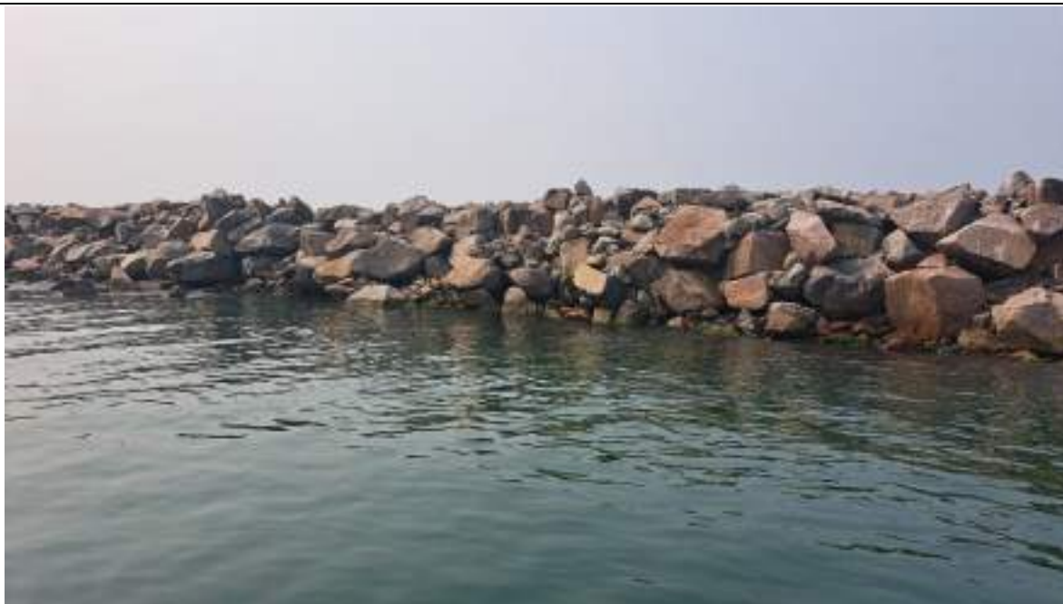
Estrutura do molhe lado Oeste.
