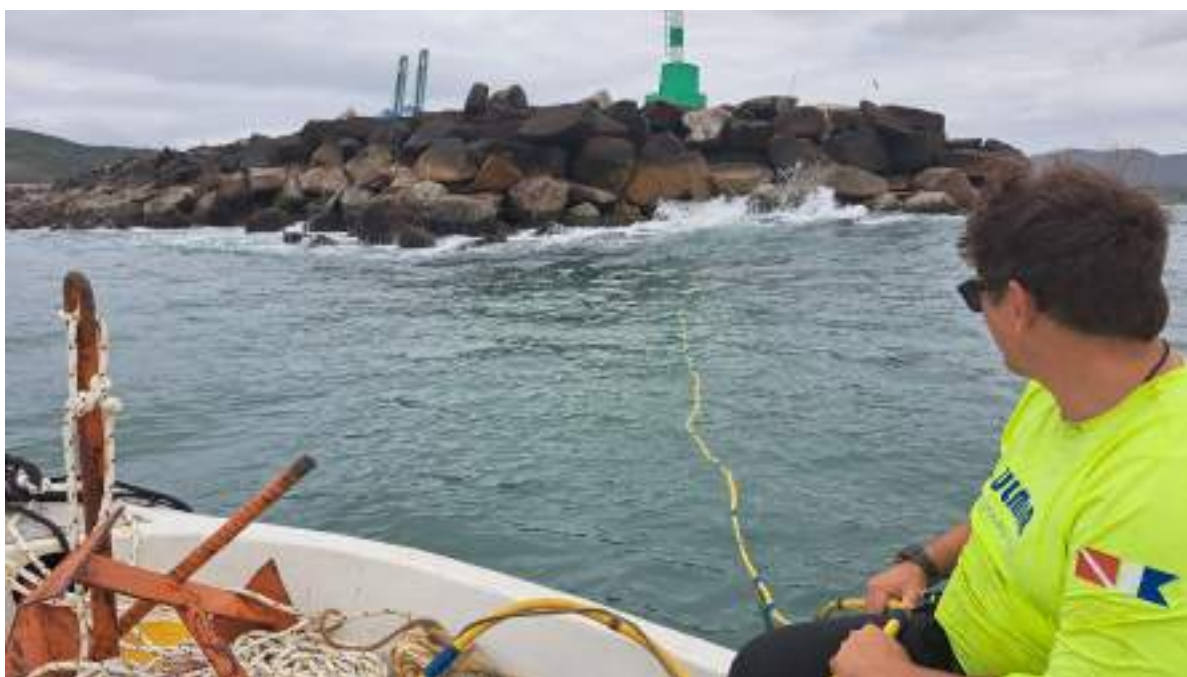
Figura 78 – Identificação da área onde foi realizada a inspeção subaquática.
