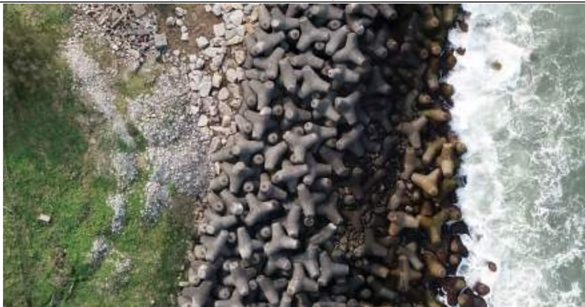
Início do molhe, lado leste (Detalhamento 1 Parte 3-5).
