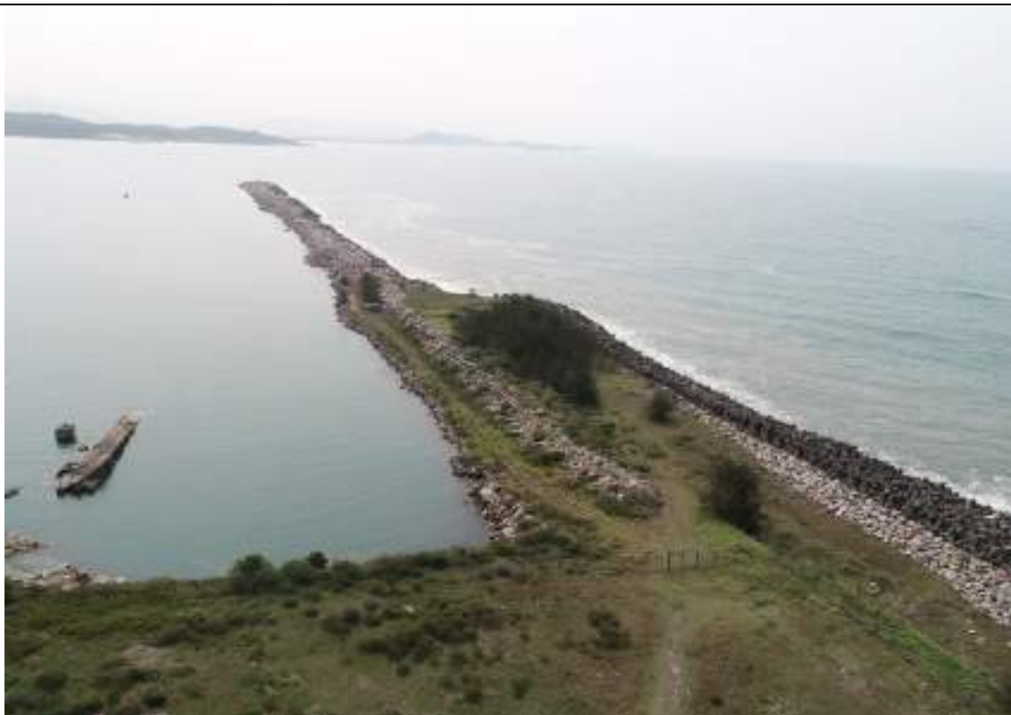
Tetrapodes, seção-17, molhe lado leste.
