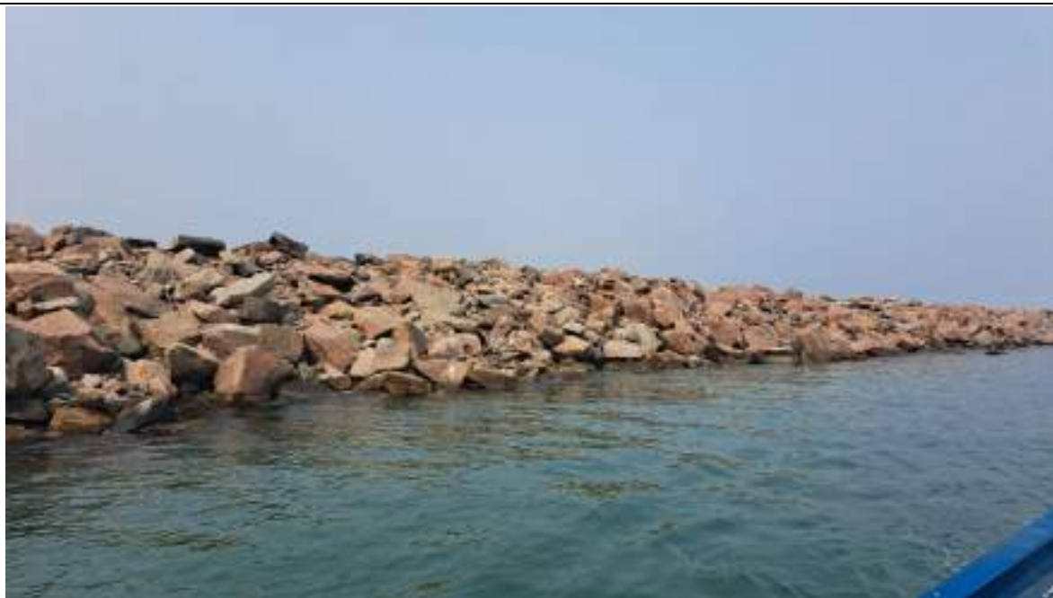
Estrutura do molhe lado Oeste.
