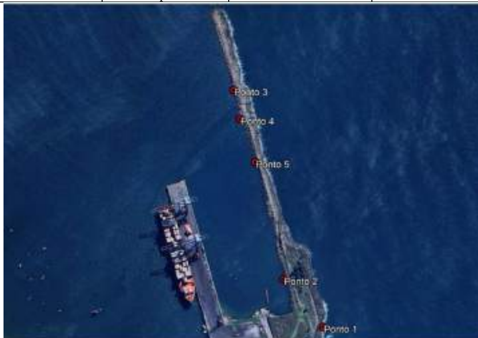
Figura 124 – Distribuição dos pontos de coleta ao longo da estrutura do molhe. Fonte: Hidrotopo, 2024.
