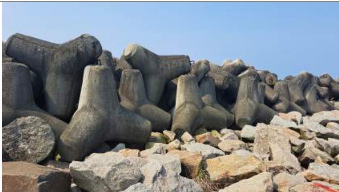
Tetrapodes, seção-17, molhe lado leste.
