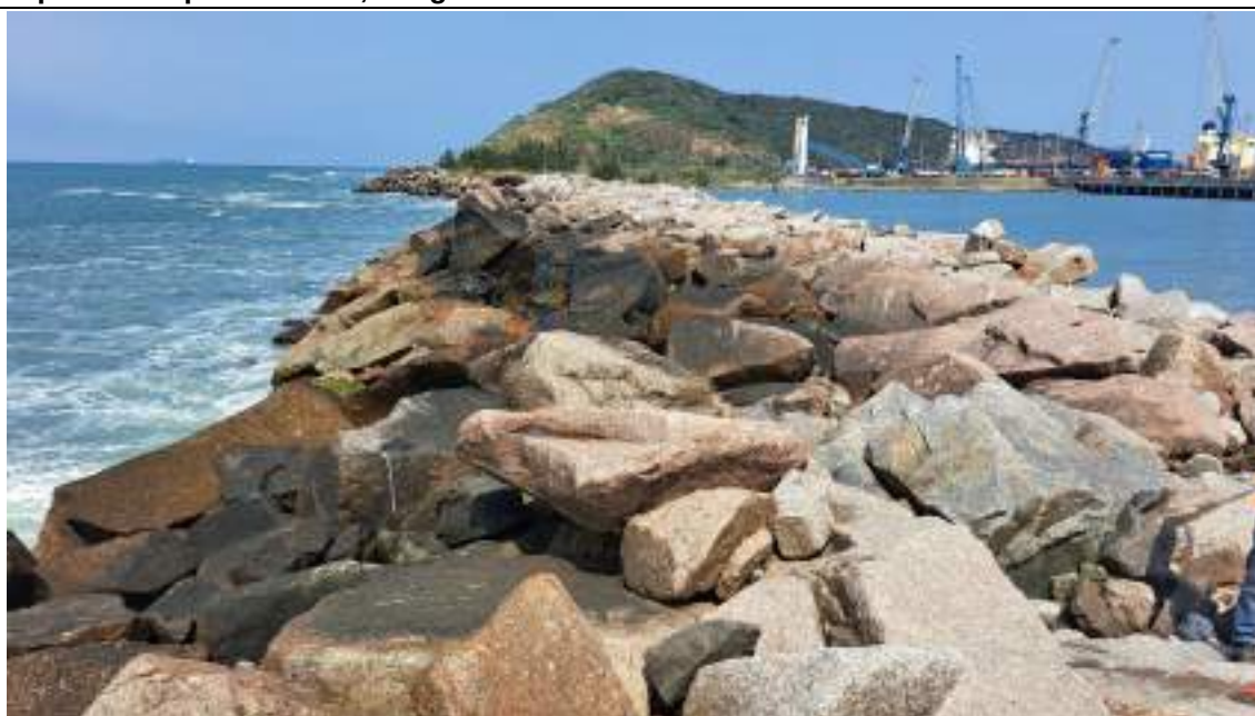
Enrocamento, vista para sul a partir da seção 55. Neste ponto, a água, ao bater no molhe, transpassa o topo do molhe, atingindo o lado oeste.
