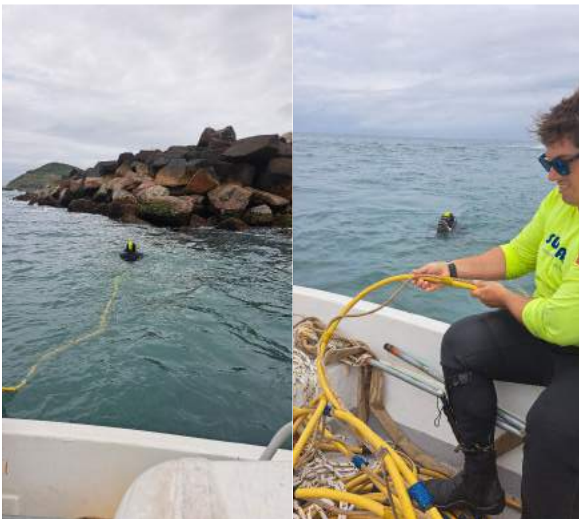
Figura 76 – Identificação da área onde foi realizada a inspeção subaquática.
