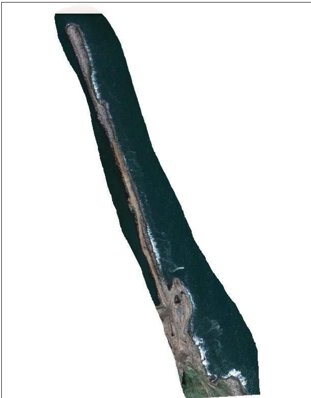
c) Recuperação da estrutura na porção norte e as obras de recuperação em andamento na porção sul do molhe - Imagem Ano 2011
