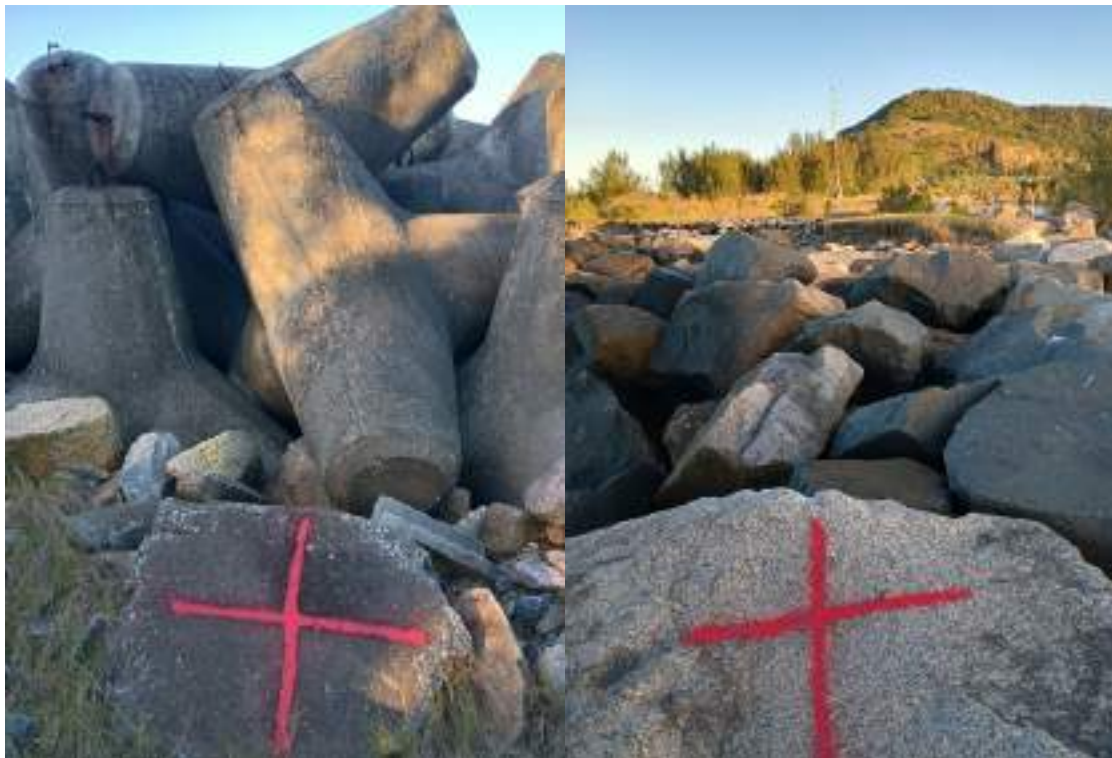
Figura 82 – Implantação dos pontos de controle.
