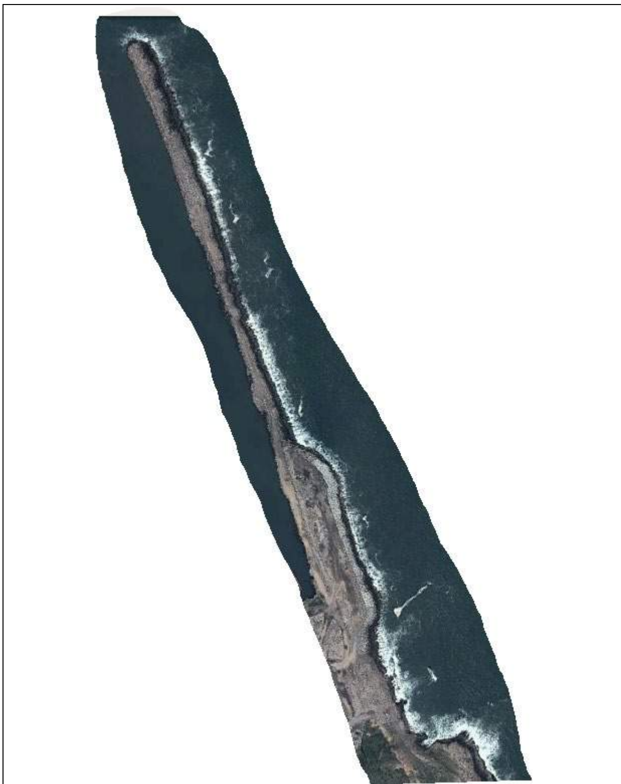
d) Obras de recuperação da estrutura concluída - Imagem Ano 2013
