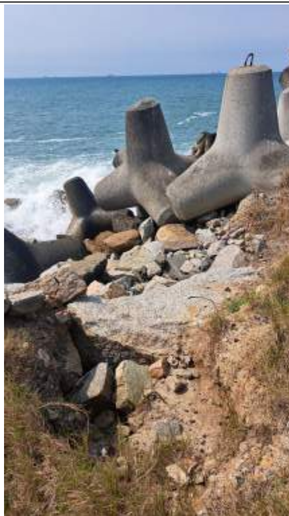
Tetrapodes, seção 31 - limite da área dos tetrápodes, molhe lado leste. Mostra a degradação provocada pela erosão.
