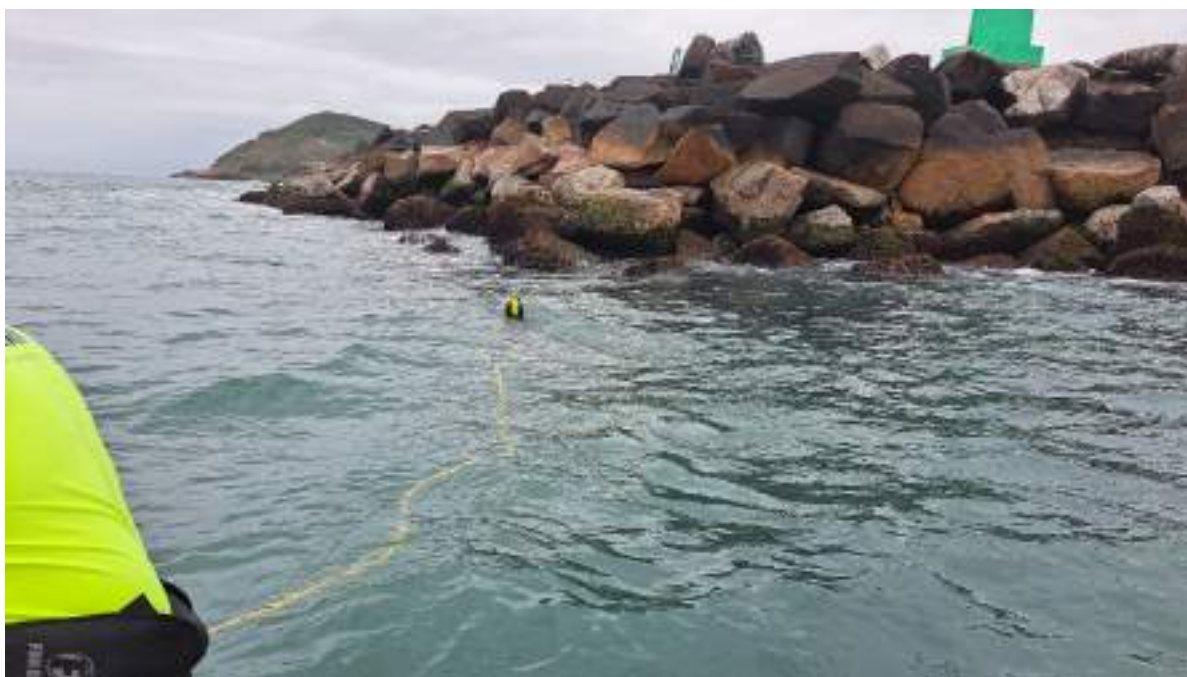
Figura 77 – Identificação da área onde foi realizada a inspeção subaquática.
