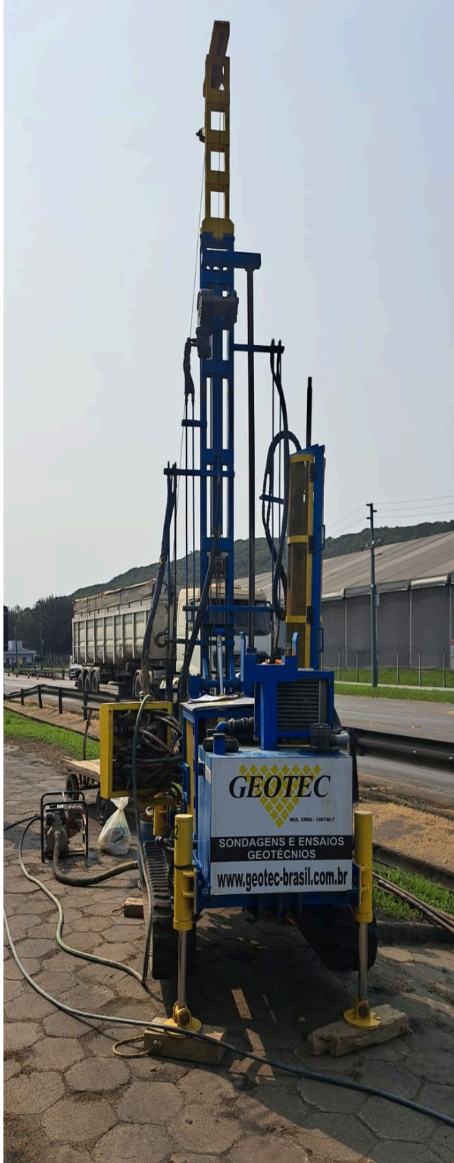
Obra Nova Balança SPT-04
