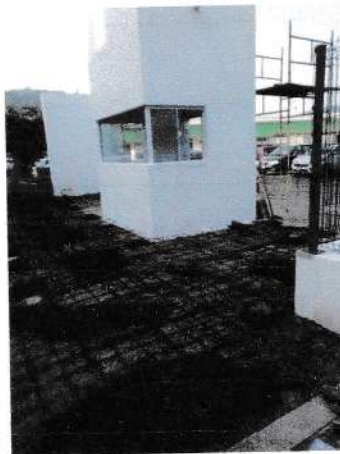
Pavimento em concreto armado.
