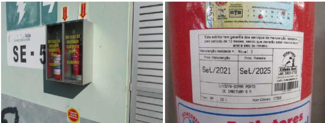
Extintor portátil e teste hidrostático
