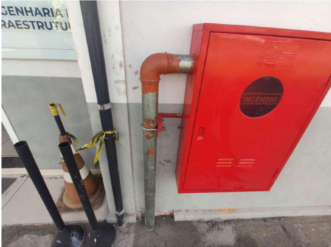
Figura 9: Hidrante parede Engenharia
