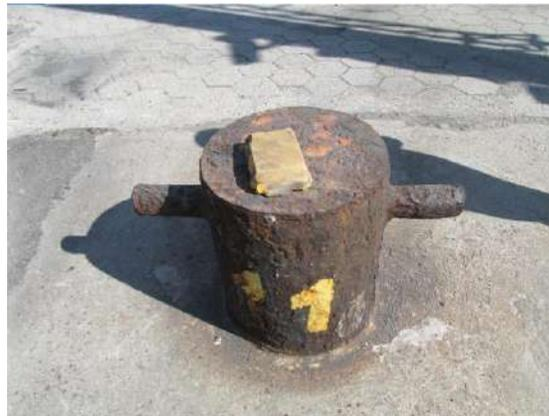
Vista de oxidação e falta de placa de especificação (capacidade)
