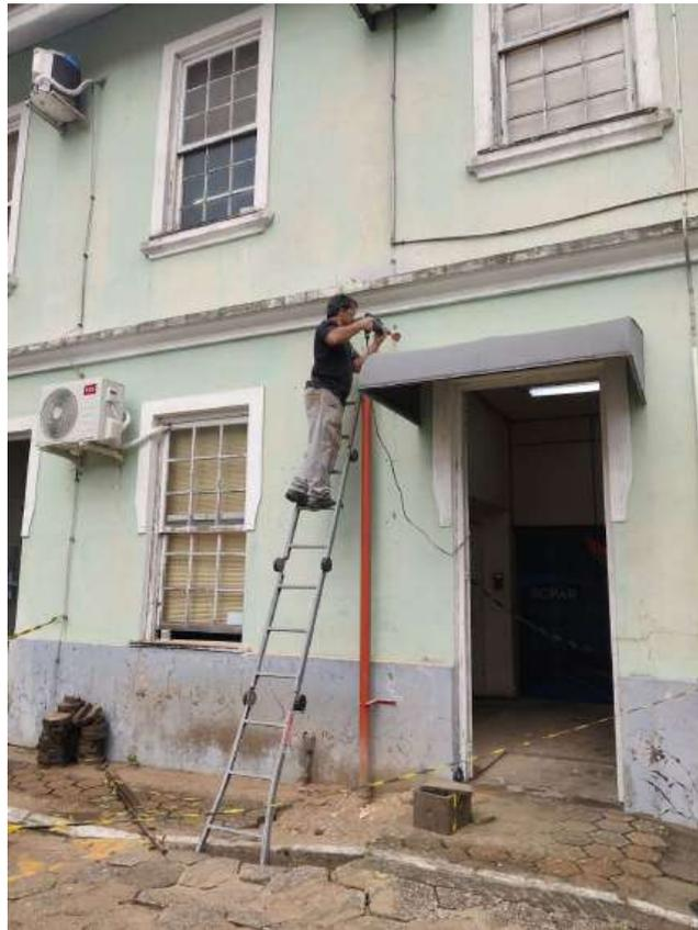
**Figura 12: Tubulação para Hidrante de parede Administração**
