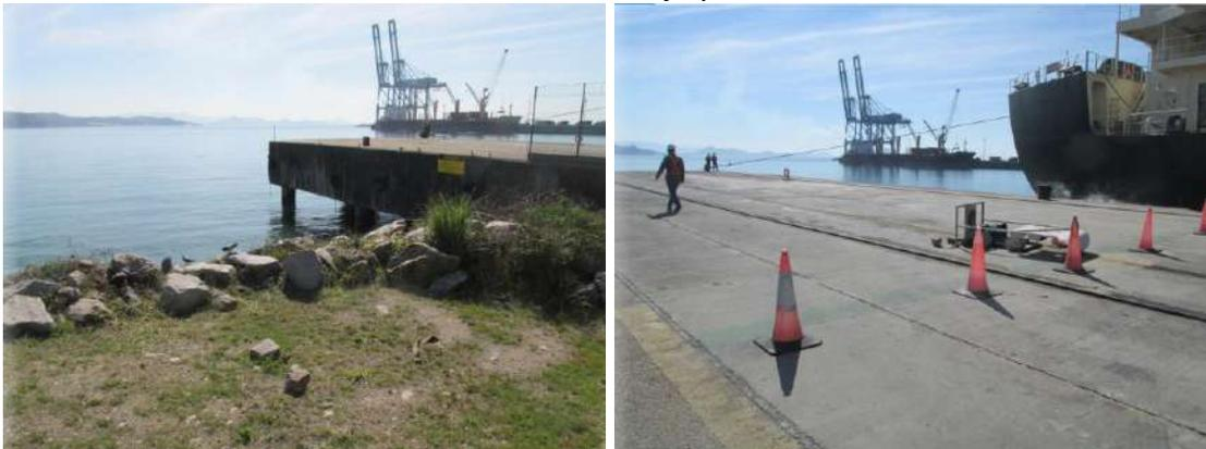
Vista de cais parcialmente interditado por existência de patologias (oxidação de armaduras)
