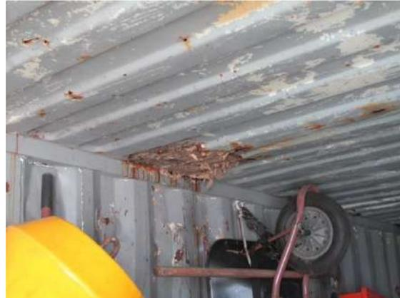
Vista de desgaste de container de armazenagem
