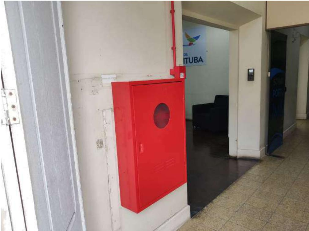
**Figura 11: Hidrante de parede Administração**
