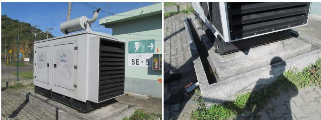
Vista do gerador de energia – Em destaque o dique de contenção
