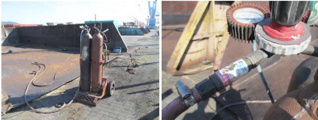
Vista da realização de corte e solda – Em destaque a válvula ante retrocesso
