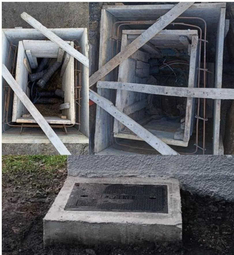
Figura 1 – Exemplo de construção de caixa de concreto armado de baixa tensão
