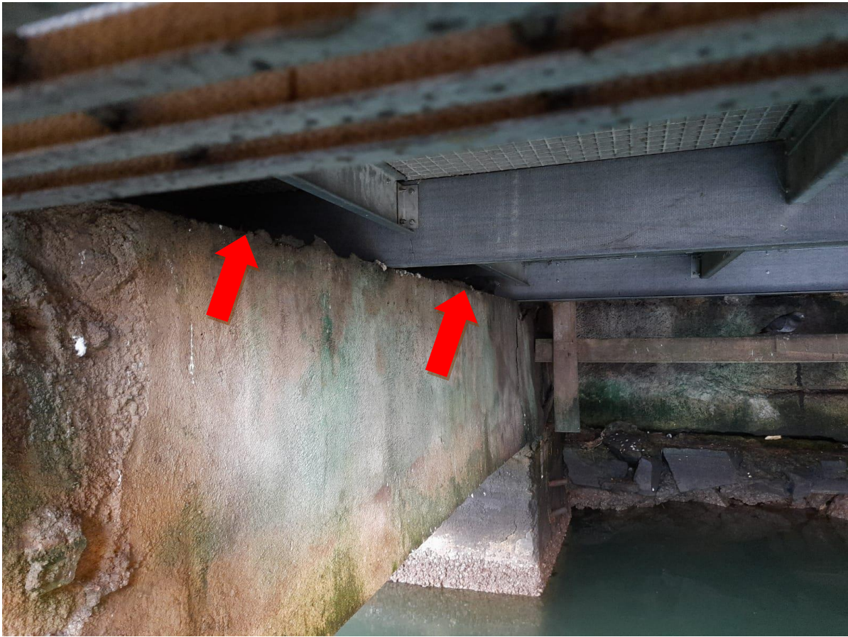
Imagem 20: Local para instalação de grade de proteção
