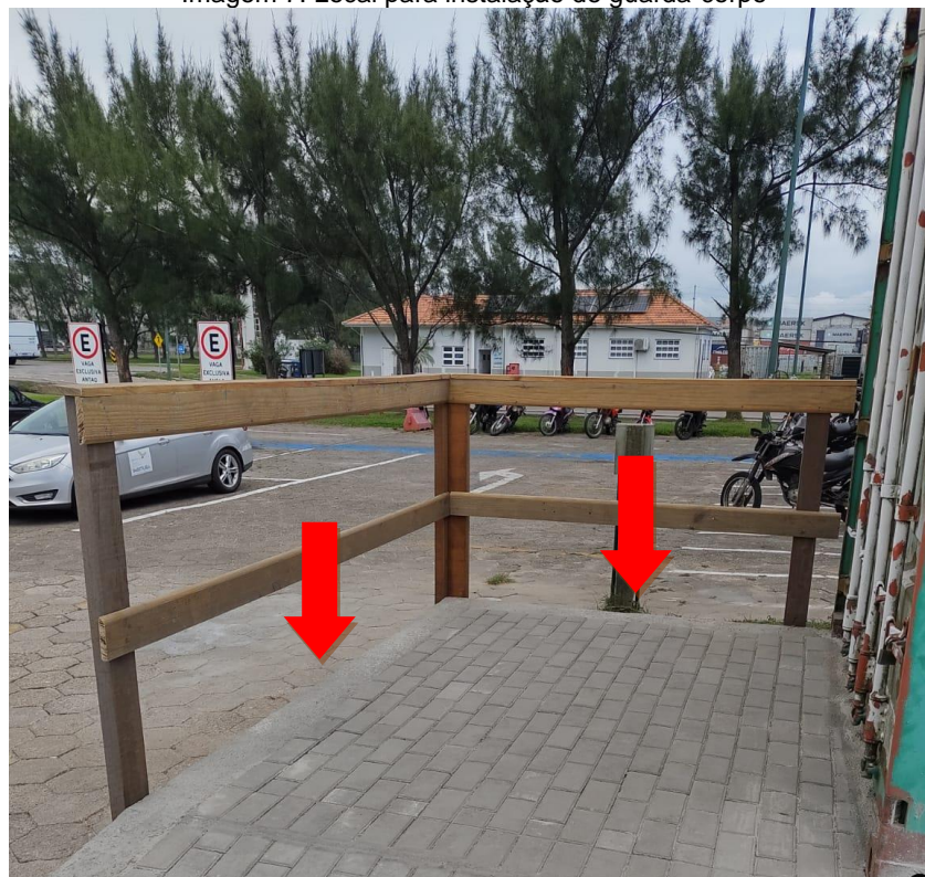
Imagem 7: Local para instalação de guarda-corpo
