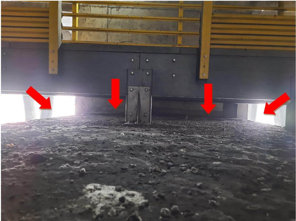
Imagem 17: Local para instalação de degrau e grade de proteção
