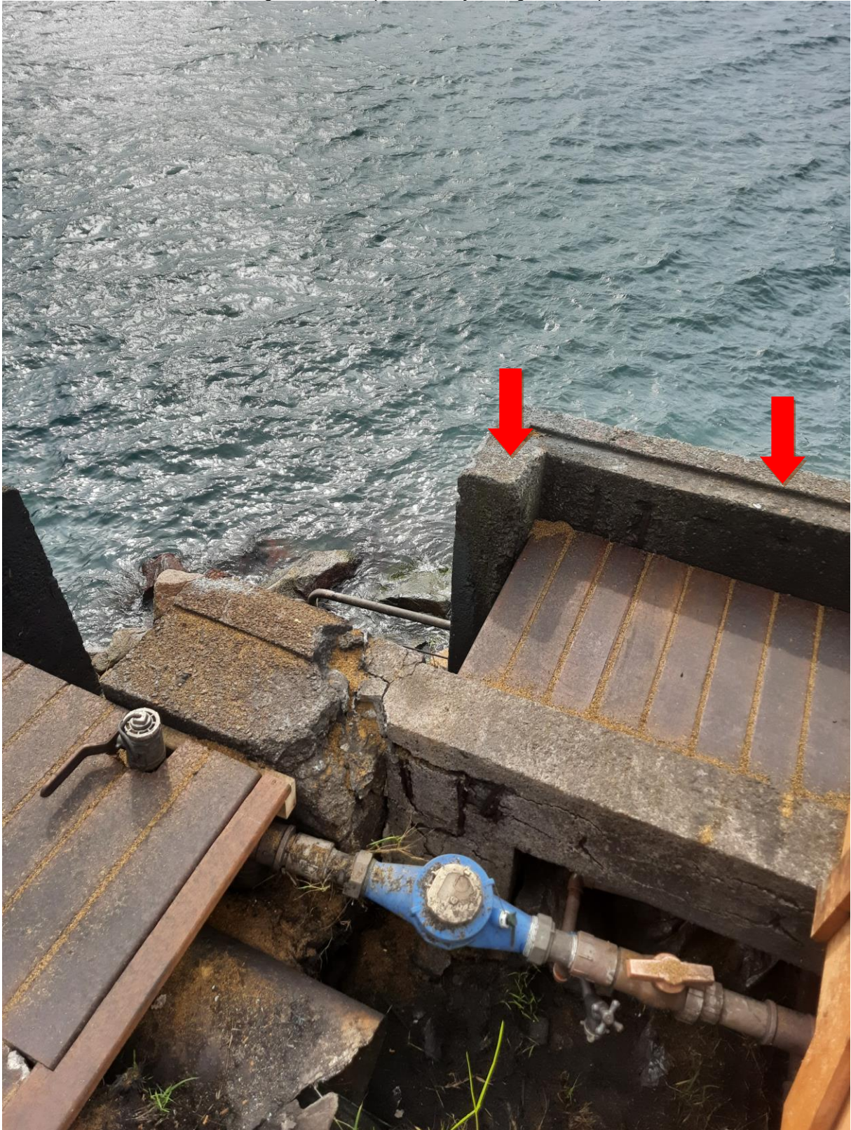
Imagem 10: Local para instalação de guarda-corpo
