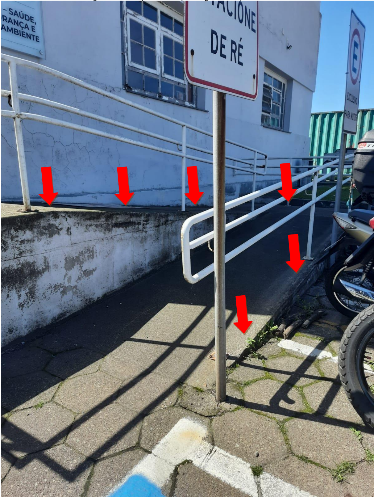
Imagem 24: Local para instalação de guarda-corpo com corrimão
