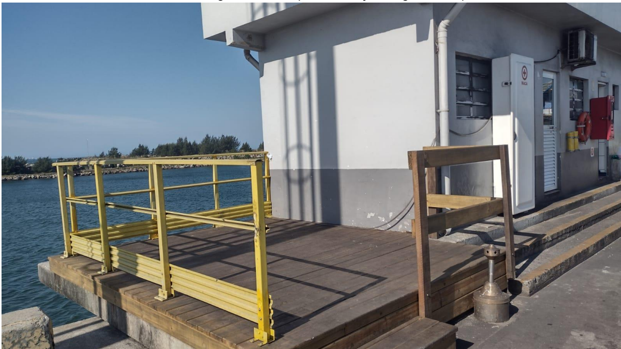
Imagem 13: Local para instalação de guarda-corpo
