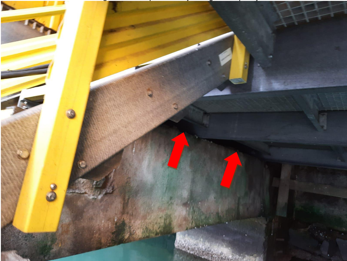
Imagem 23: Local para instalação de grade de proteção
