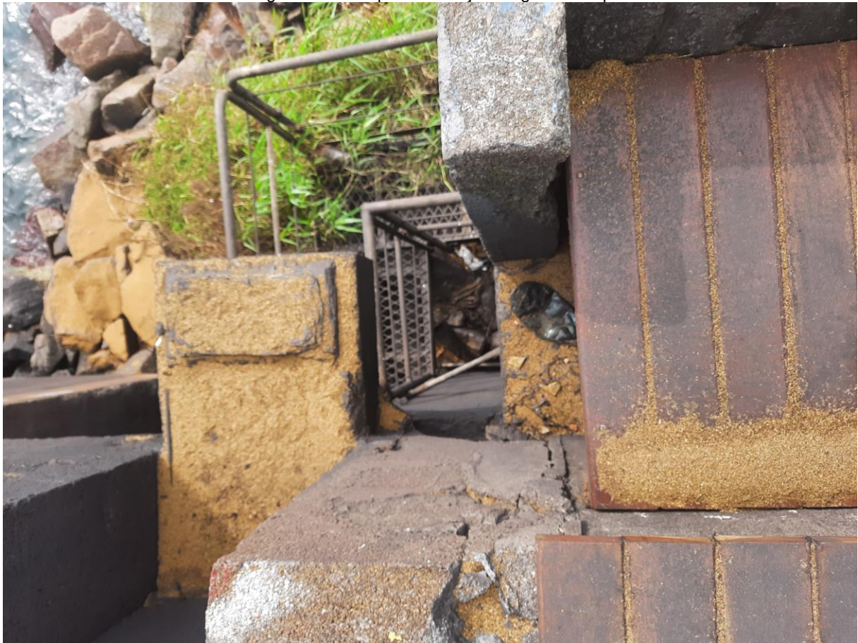
Imagem 11: Local para instalação de guarda-corpo
