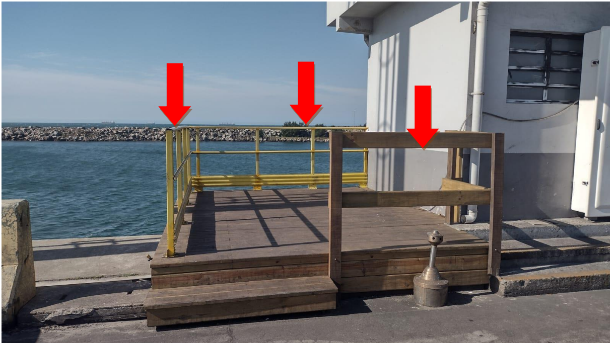
Imagem 12: Local para instalação de guarda-corpo
