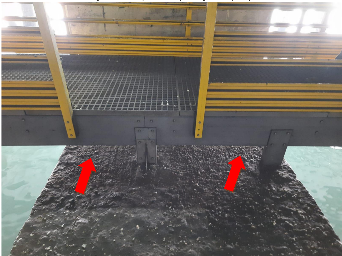
Imagem 21: Local para instalação de grade de proteção
