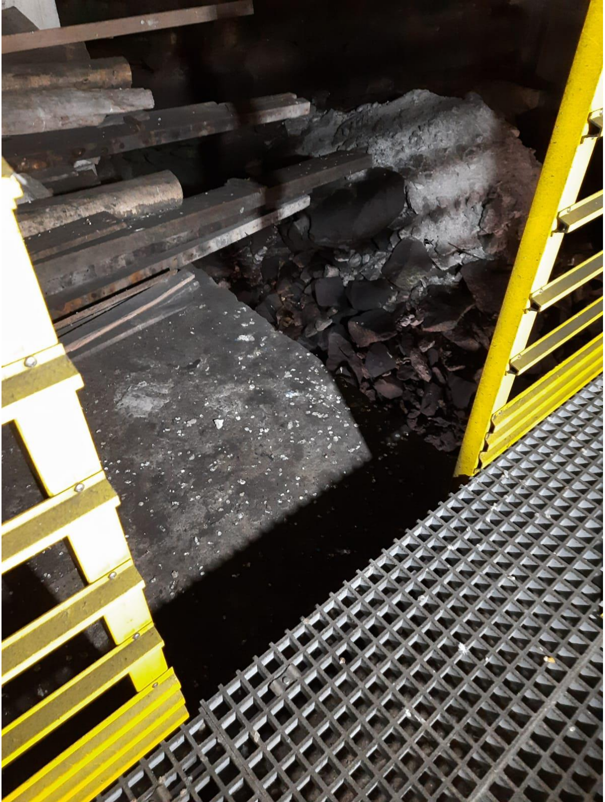
Imagem 14: Local para instalação de portão
