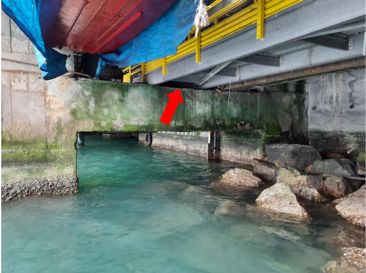
Imagem 18: Local para instalação de grade de proteção
