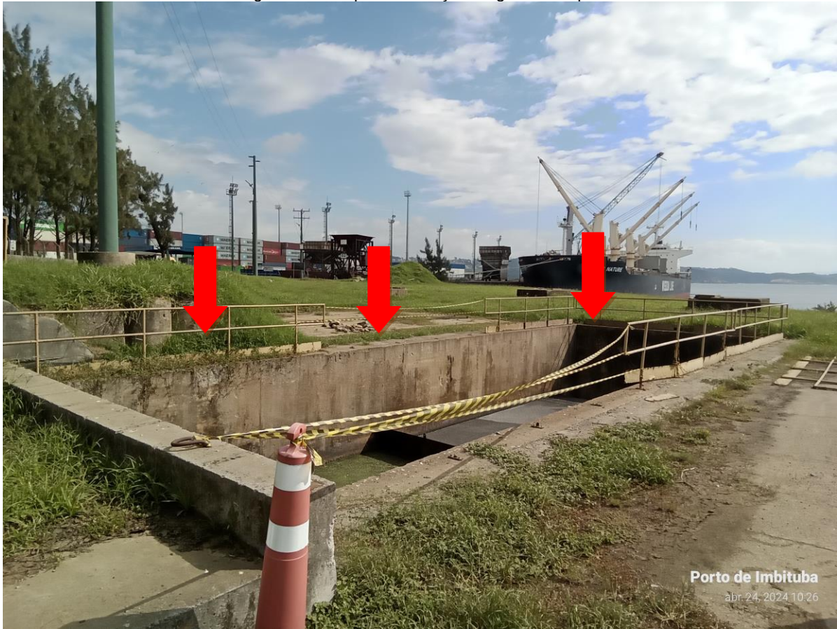
Imagem 1: Local para instalação do guarda-corpo fixo
