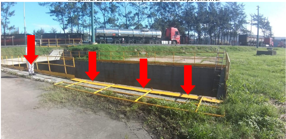
Imagem 2: Local para instalação do guarda-corpo removível
