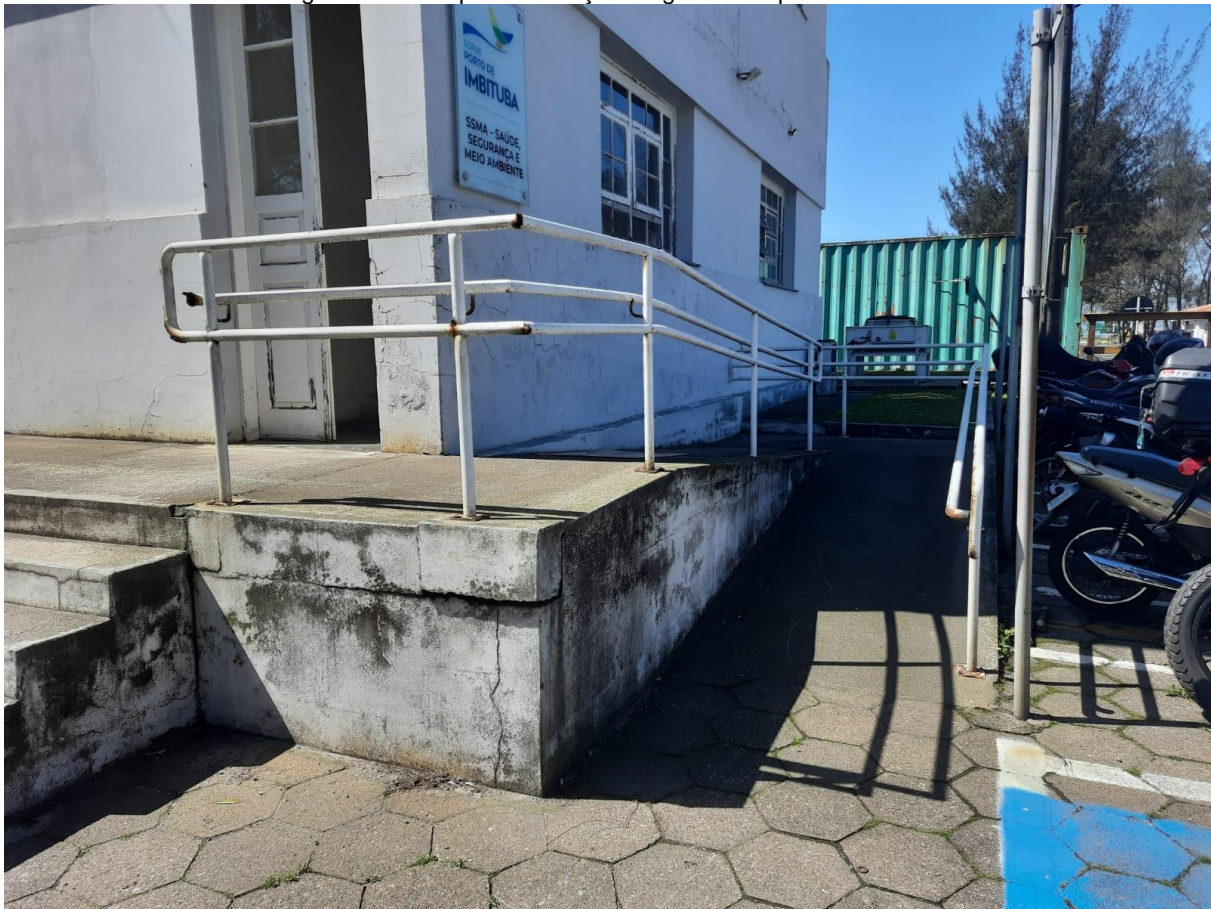
Imagem 25: Local para instalação de guarda-corpo com corrimão
