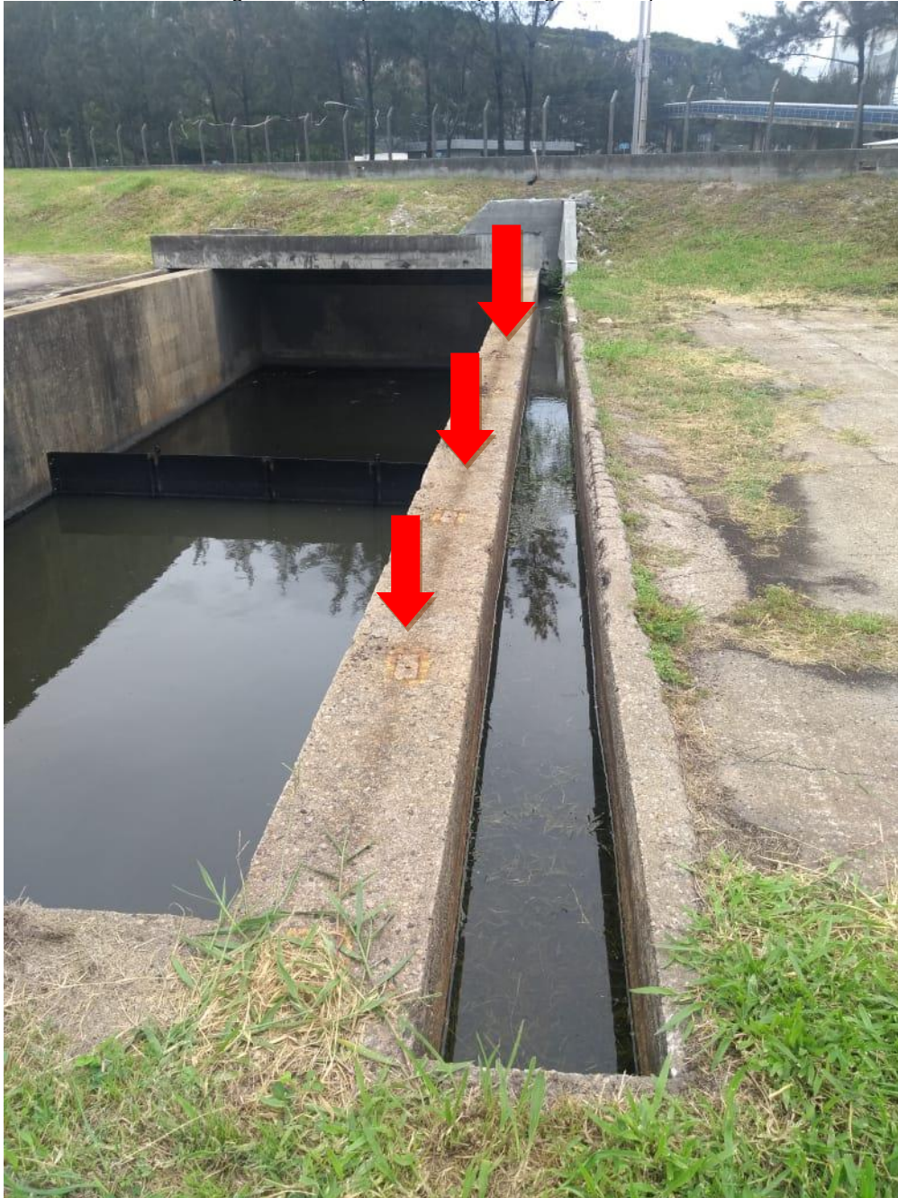
Imagem 3: Local para instalação do guarda-corpo fixo
