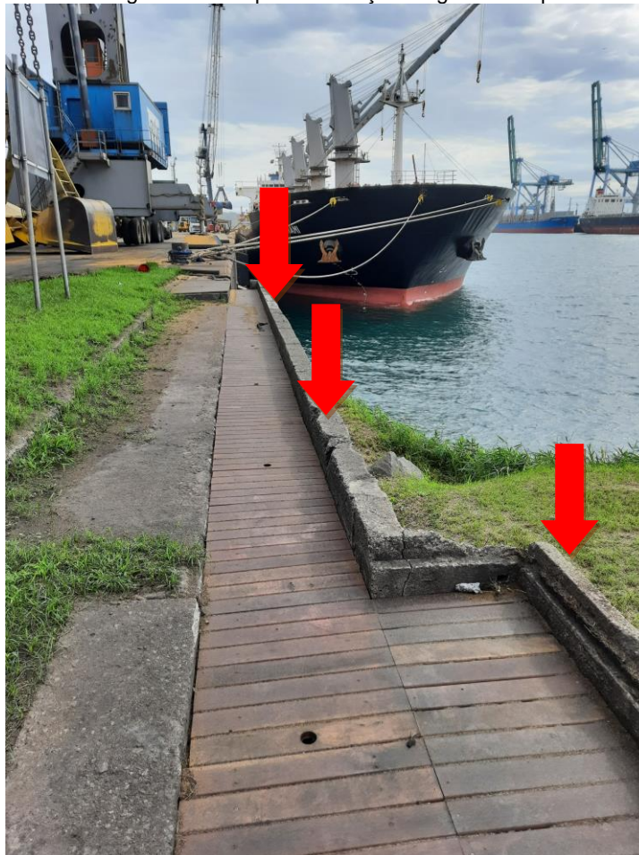
Imagem 8: Local para instalação de guarda-corpo
