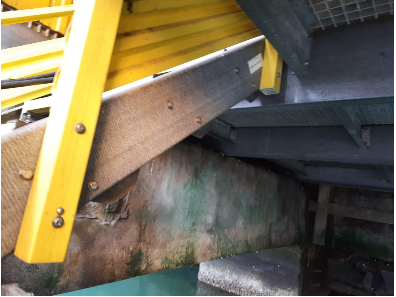
Imagem 26: Local com necessidade de acesso por embarcação
