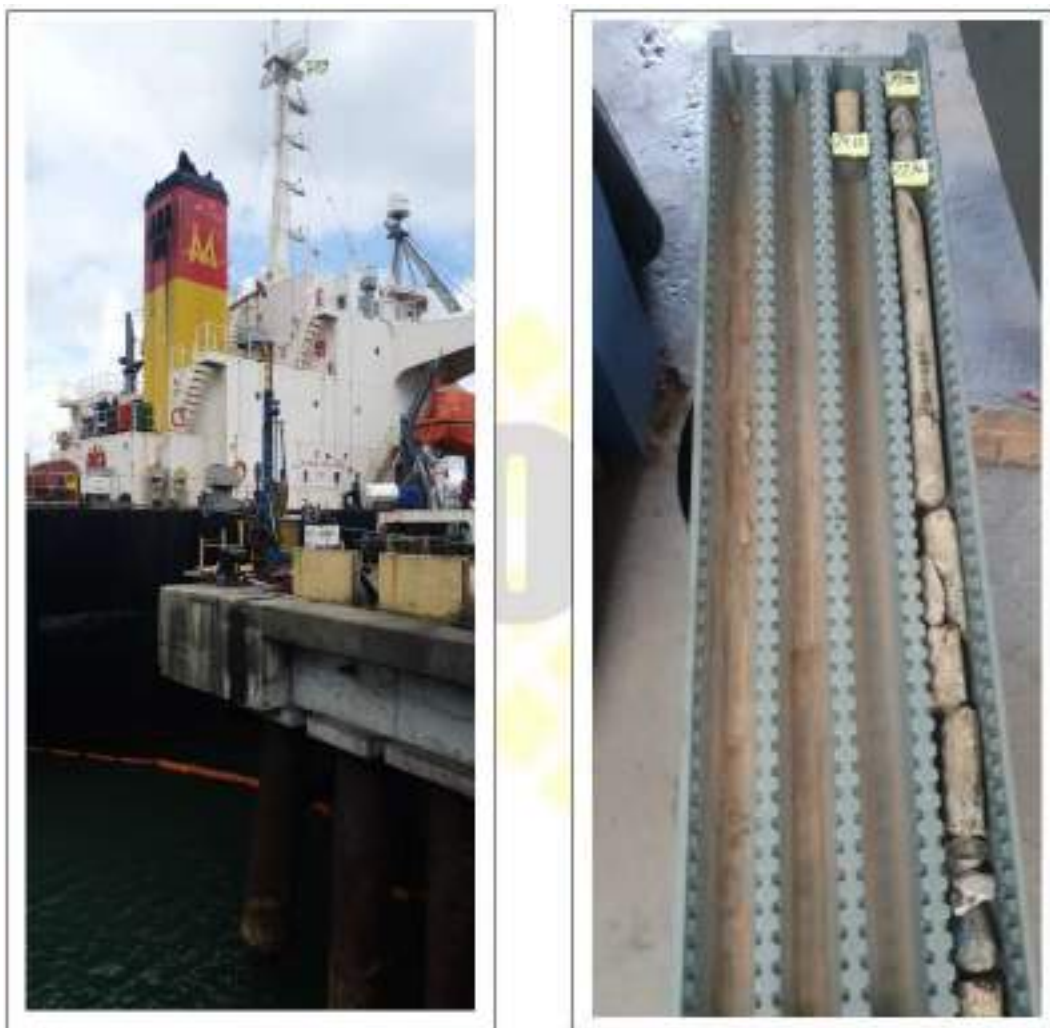
Figura 28: Fotos da execução e testemunhos do ponto S02.
