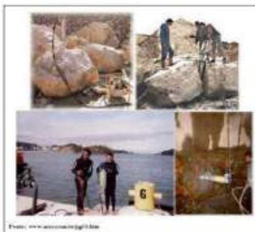
Figura 6: Derrocamento a frio com mergulhadores.
