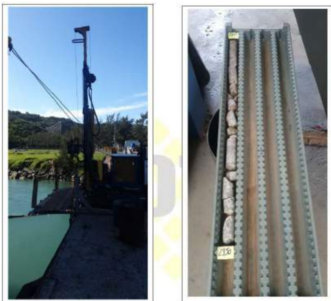
Figura 33: Fotos da execução e testemunhos do ponto S03.
