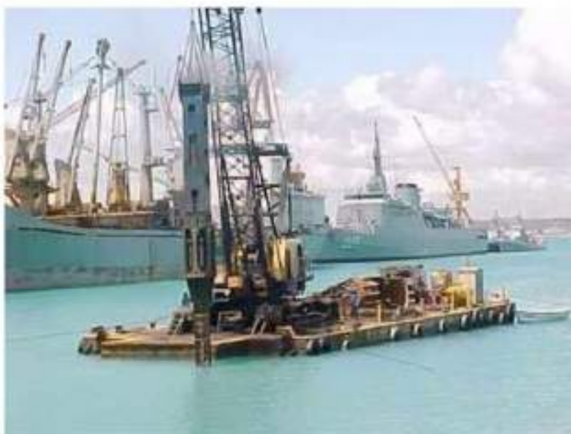
Figura 4: Derrocamento a frio com derrocadeira.
