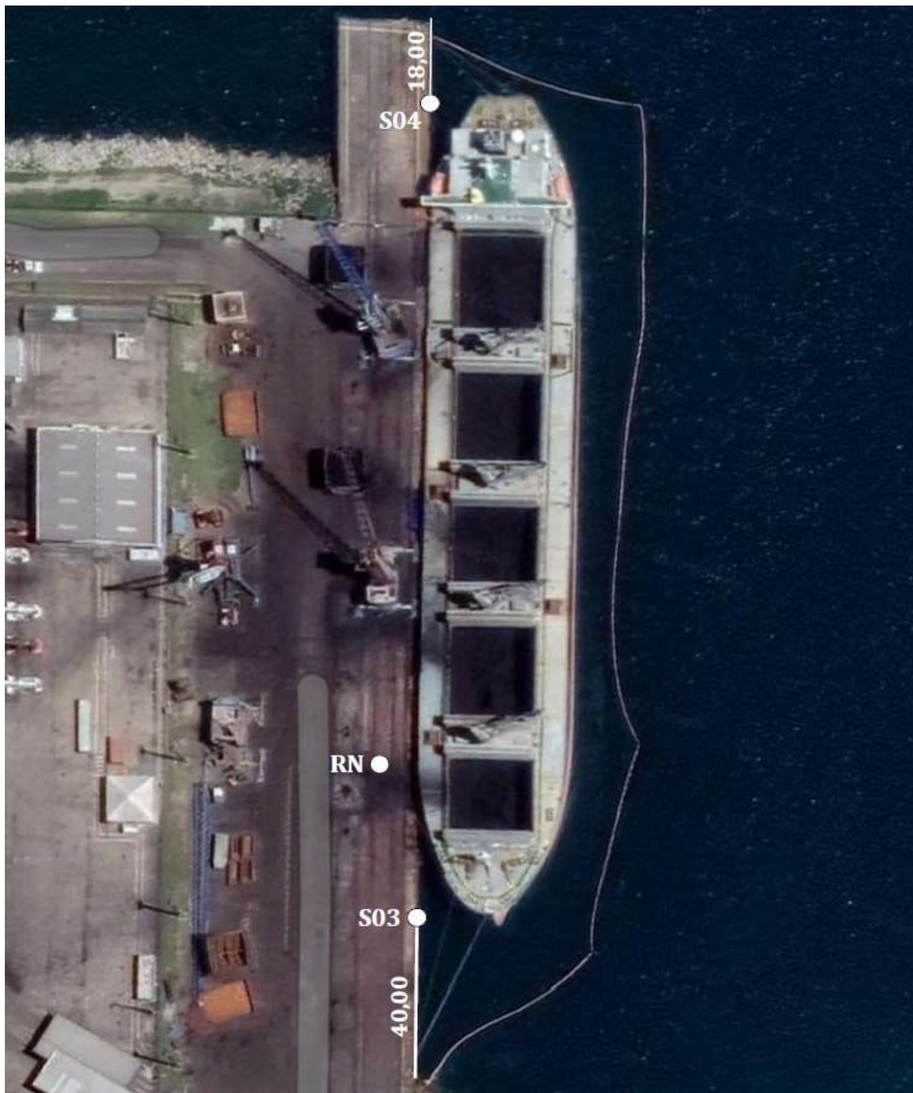
Figura 32: Localização dos pontos de sondagem do cais 3.
