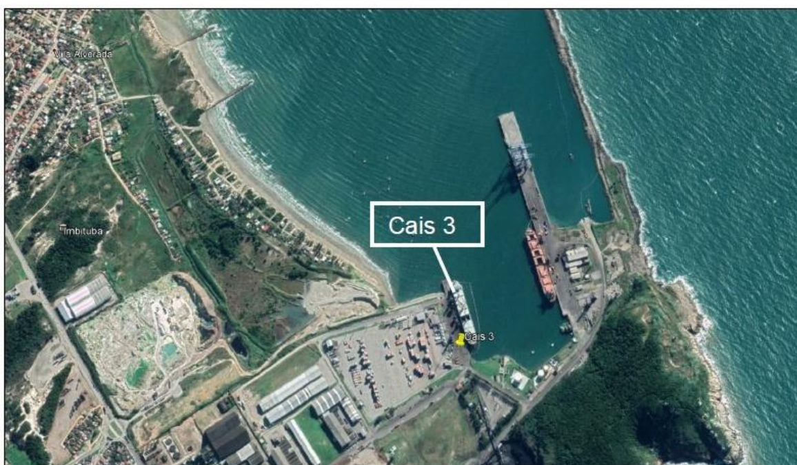
Figura 1 – Localização do Cais 3 no Porto de Imbituba
