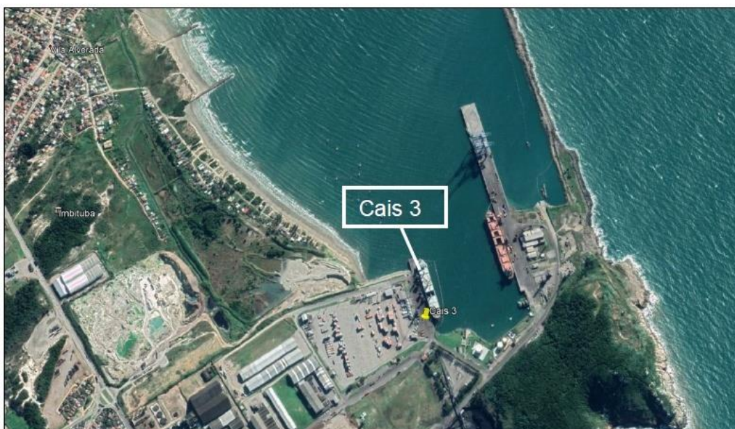
Figura 1 – Localização do Cais 3 no Porto de Imbituba
