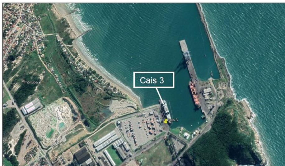
Figura 2 - Localização do Cais 3 no Porto de Imbituba / SC ( 28^{\circ}13'55.04''S ; 48^{\circ}39'14.25''O ).
