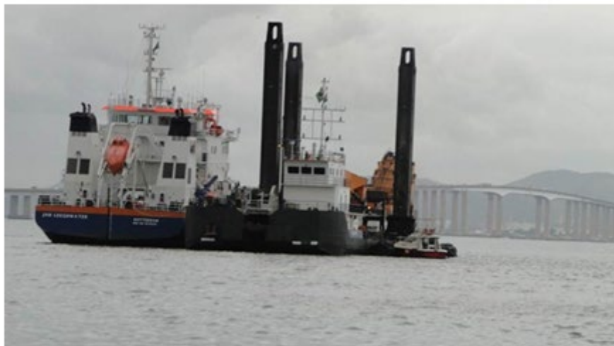
Figura 5- Draga do tipo Back Hoe com batelão a contrabordo.
