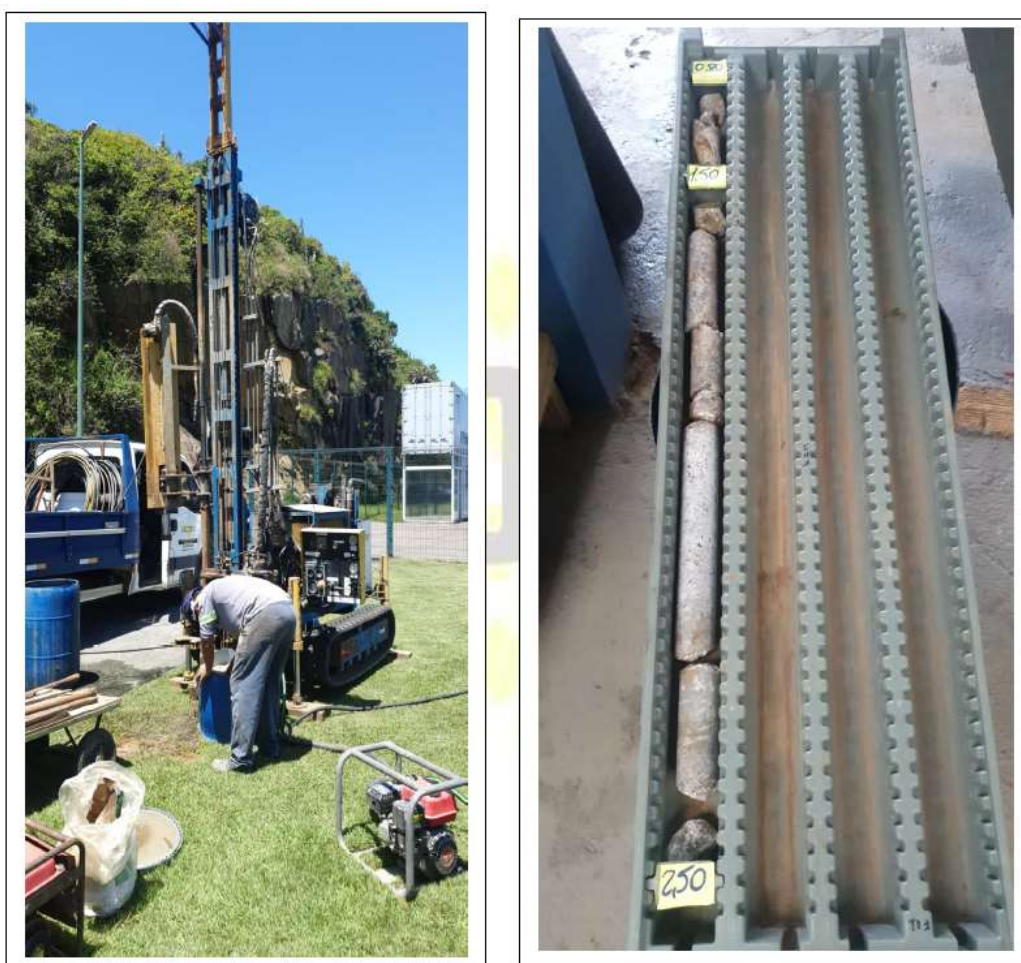
Figura 30: Fotos da execução e testemunhos do ponto S01A.
