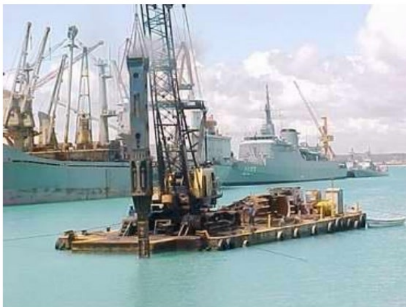
Figura 4: Derrocamento a frio com derrocadeira.
