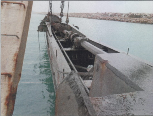
Foto 7- Linha de eixo do desagregador.
