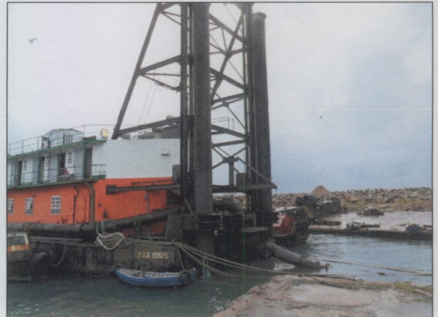
Foto 2-Vista dos dois charutos (“spuds”).
