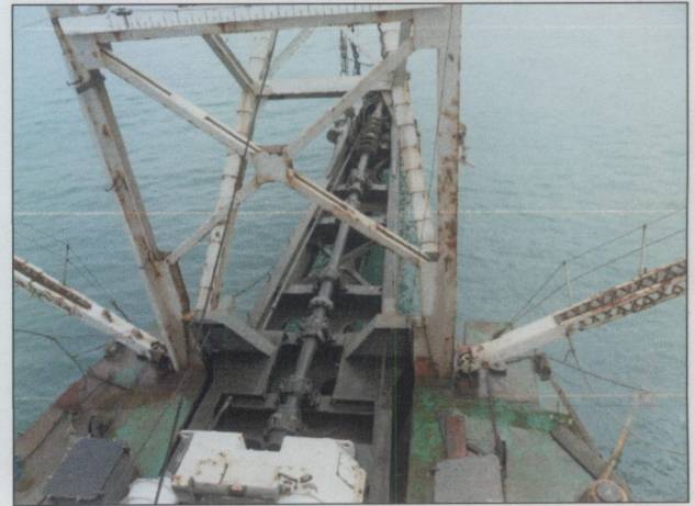
Foto 10- Torre da lança de dragagem.
