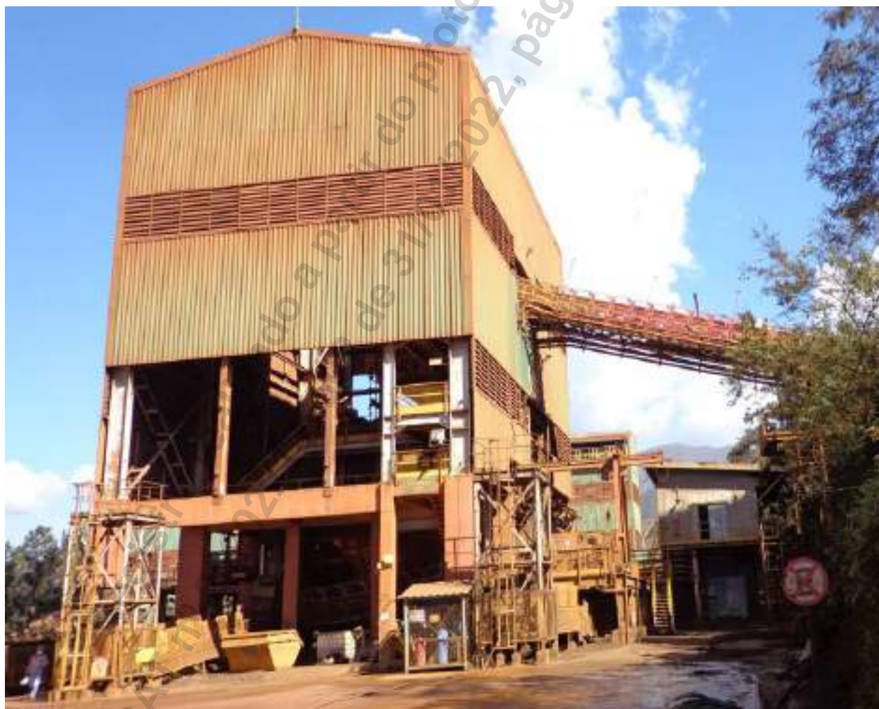
Figura 1: Prédio de Peneiramento (IB3)
