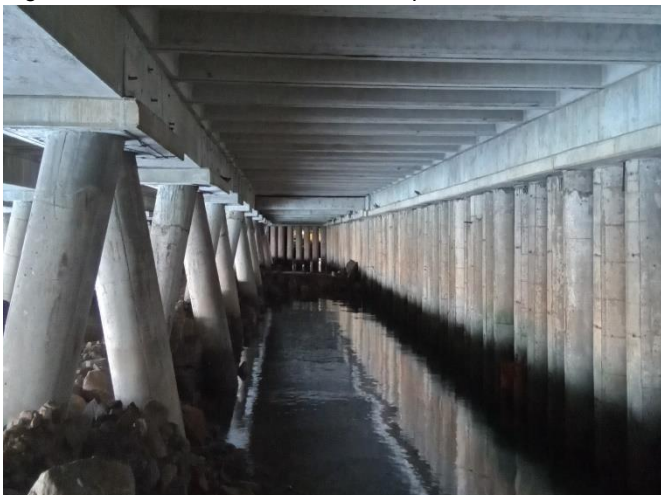
Figura 8. Sobras de concreto onde os pombos tem livre acesso para nidificar.
