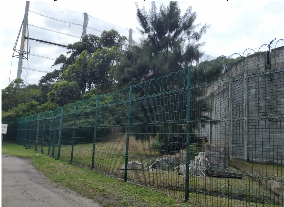
Figura 09 – Modelo de instalação de Concertina com espera
