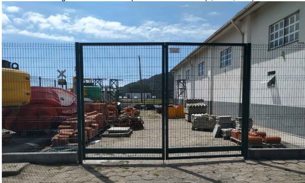
Figura 05 – Modelo de portão a ser instalado (4,00 x 2,73 m)
