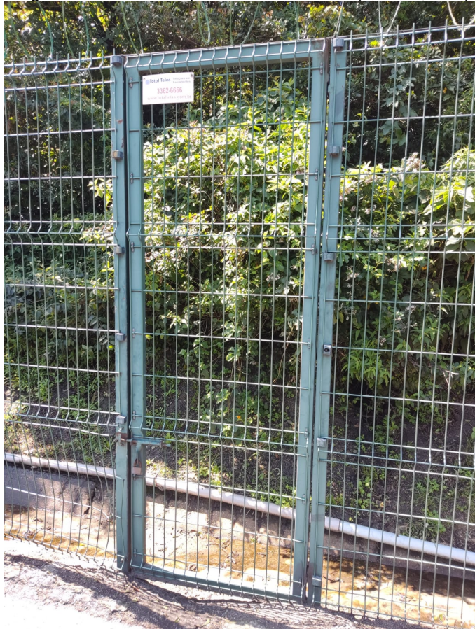
Figura 04 – Modelo de portão a ser instalado (1,00 x 2,73 m)
