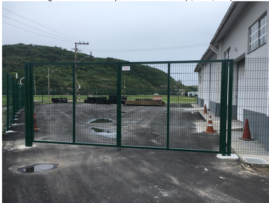
Figura 06 – Modelo de portão a ser instalado (6,00 x 2,73 m)
