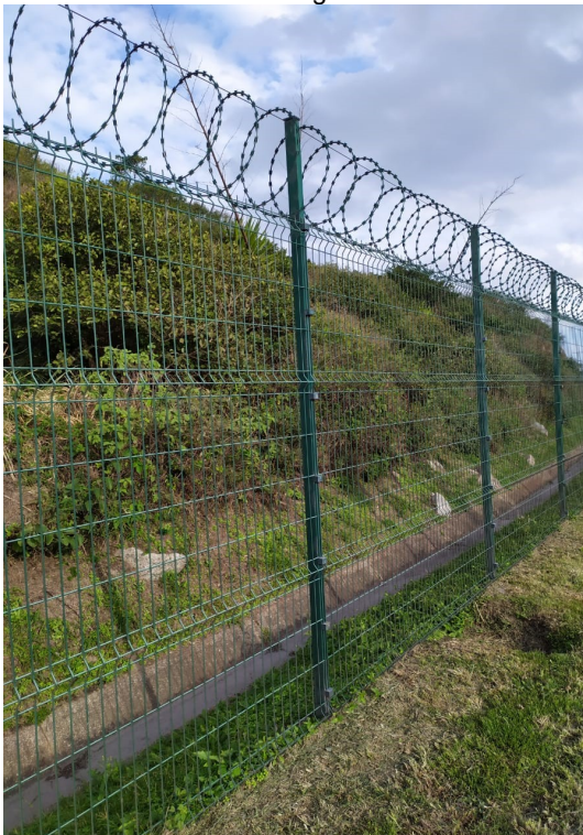
Figura 08 – Concertinas instaladas na SCPAR Porto de Imbituba
