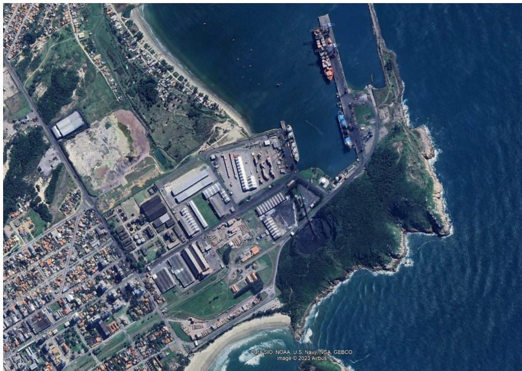
Figura 1 - Localização do Porto de Imbituba / SC (28°13'56.00"S; 48°39'8.00"O)
