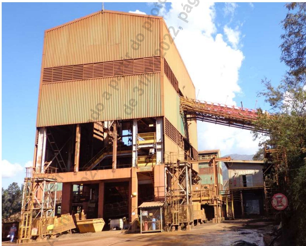
Figura 1: Prédio de Peneiramento (IB3)
