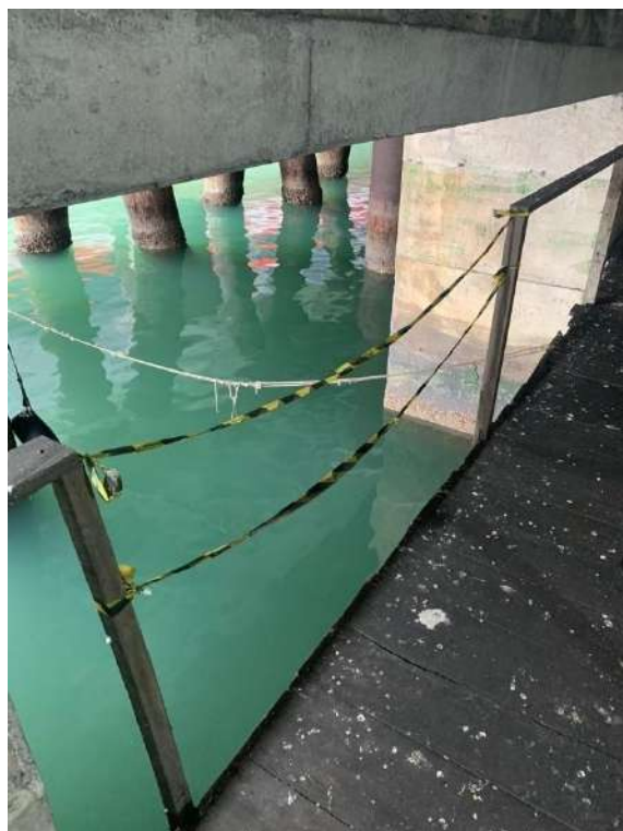
Figura 05 – Comprometimento de guarda-corpo
