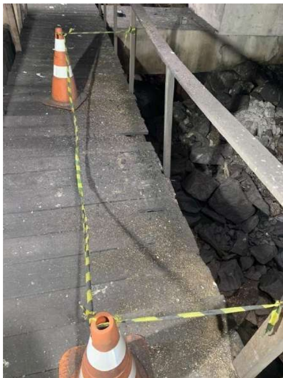
Figura 05 – Comprometimento de guarda-corpo
