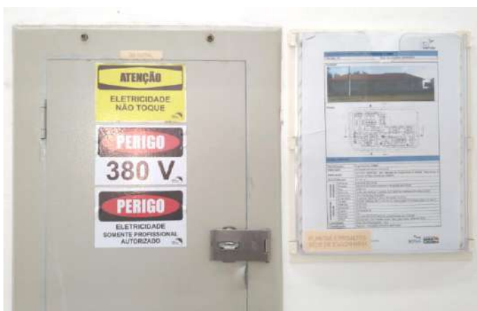
Figura 135 – Adesivos de advertência, projetos e diagramas ao lado do QGBT. Fonte: Acervo próprio.
