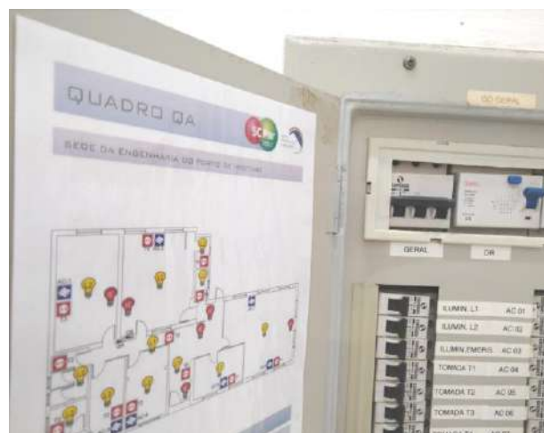
Figura 136 - Diagrama ilustrativo no verso da porta do QGBT e identificação dos disjuntores. Fonte: Acervo próprio.
