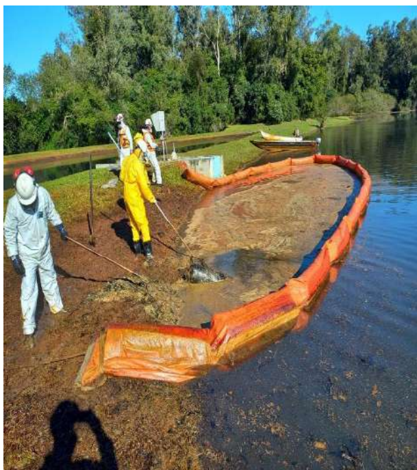
Remoção do material residual sólido
