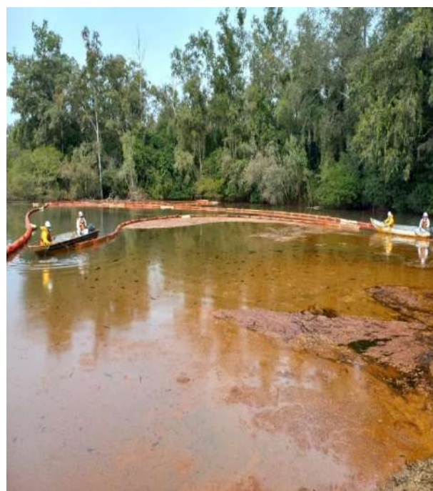
Reposicionamento e arraste das barreiras de contenções
