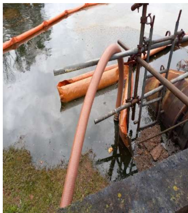
Sucção do material residual
