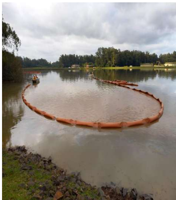
Auxílio nos trabalhos com apoio do soprador mecânico e confinamento do produto
