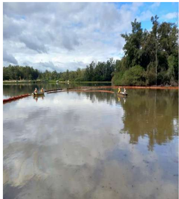
Reposicionamento e arraste das barreiras de contenções
