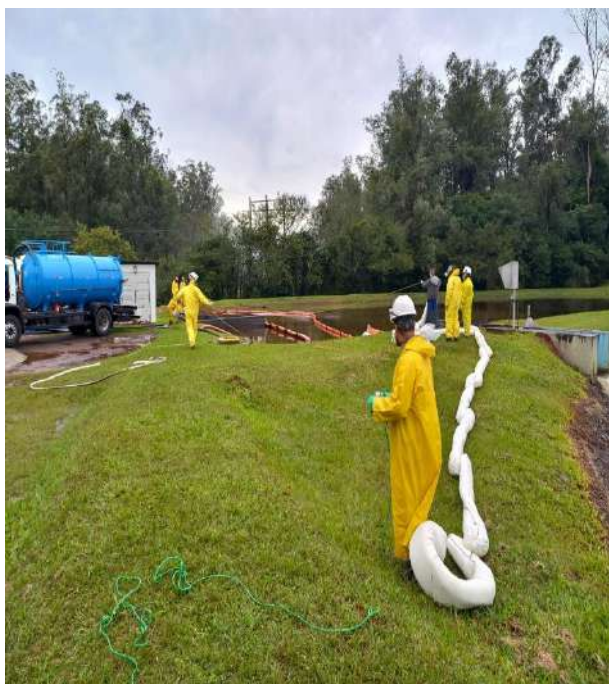
Posicionamento de barreiras absorventes
