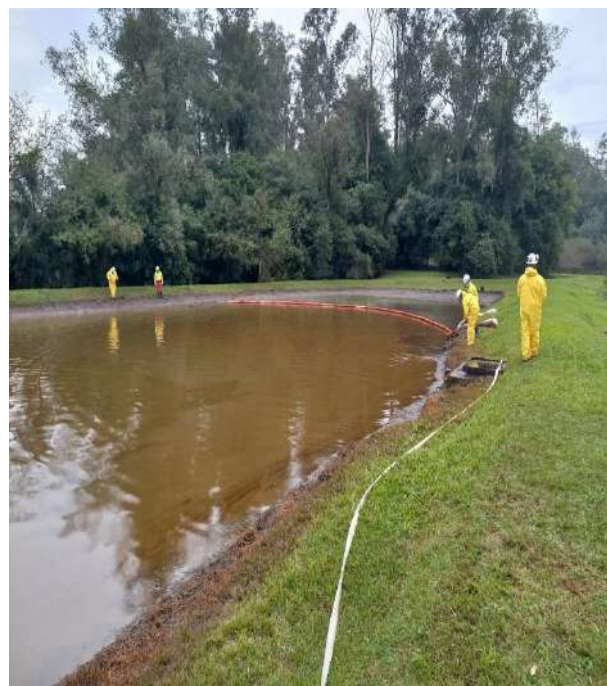
Posicionamento de barreiras absorventes
