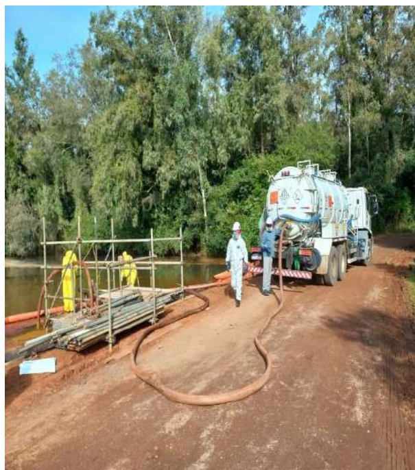
Sucção do material residual
