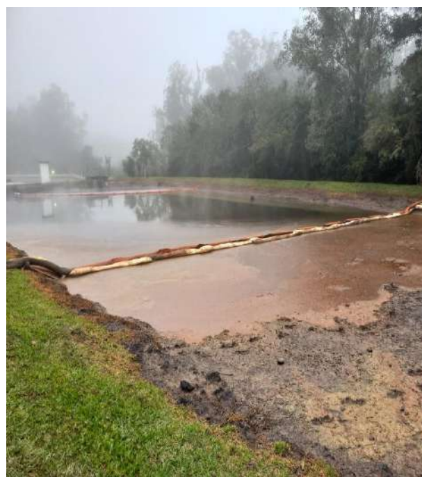
Barreiras absorventes e de contenção posicionadas na lagoa
