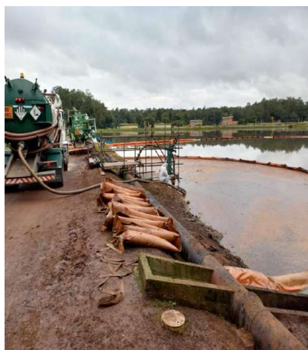
Sucção do material residual
