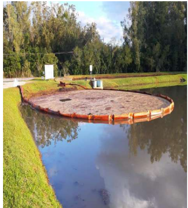
Produto confinado na barreira
