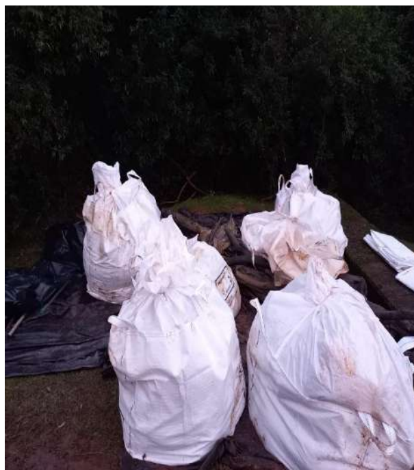
Resíduos acondicionados em big bags
