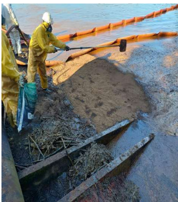
Aplicação de turfa no produto confinado nas barreiras de contenções
