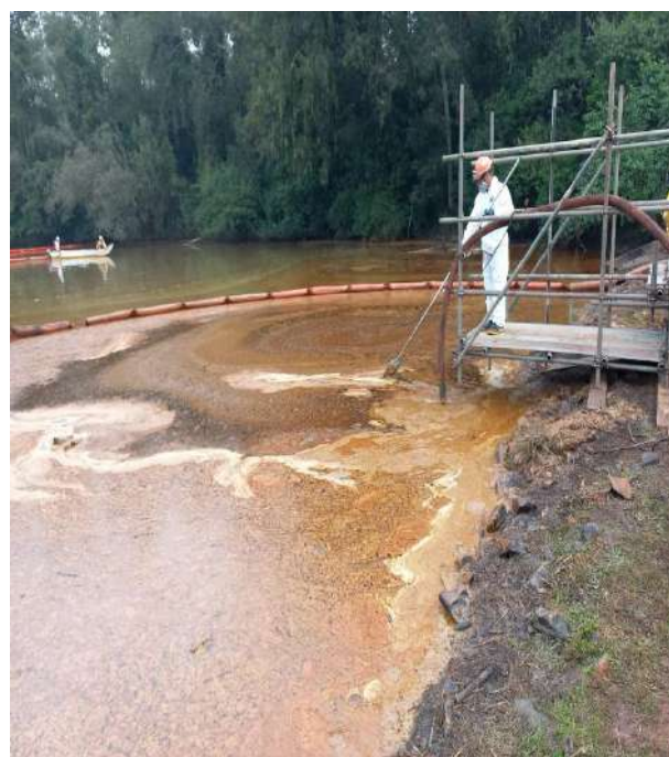
Sucção do material residual líquido
