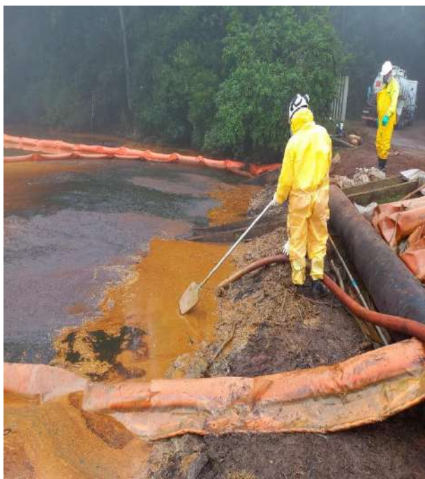
Sucção do material residual líquido
