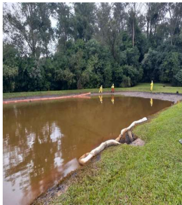
Posicionamento de barreiras absorventes
