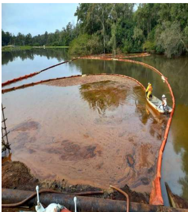
Reposicionamento e arraste das barreiras de contenções
