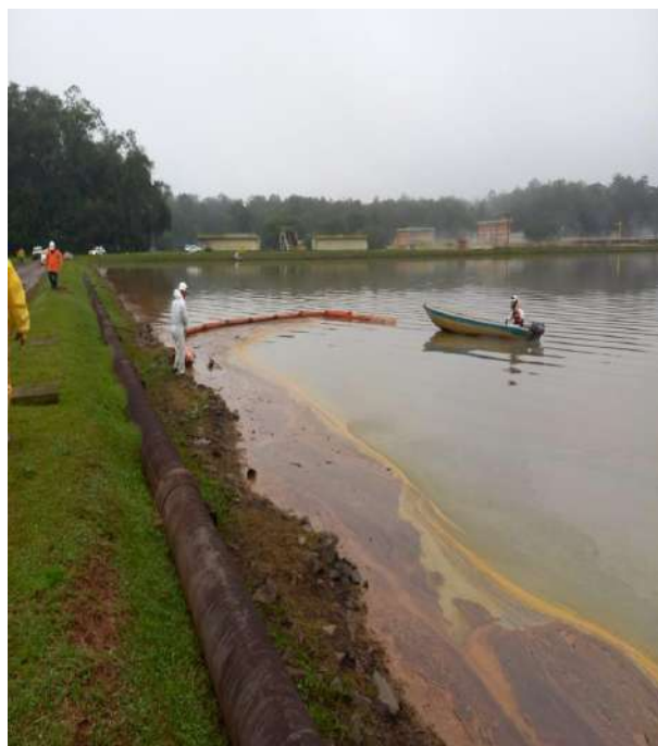
Arraste da barreira de contenção
