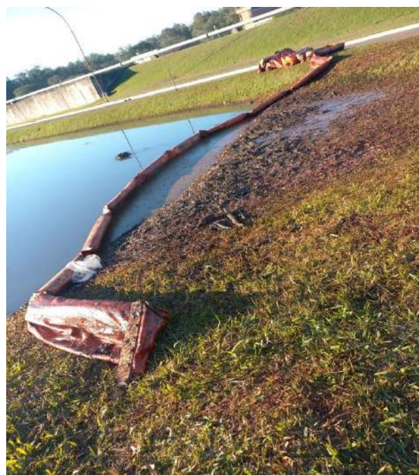
Remoção das barreiras de contenções
