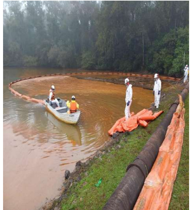
Confinamento do material residual
