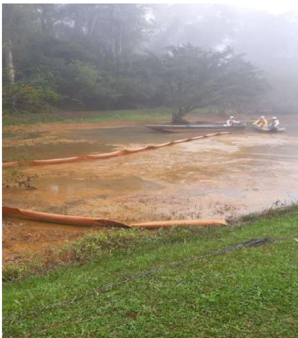
Reposicionamento e arraste das barreiras de contenções
