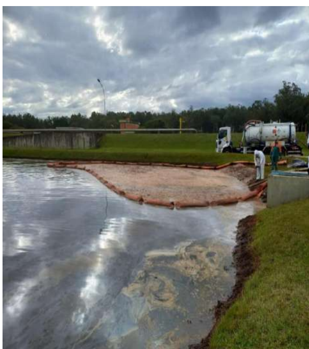
Sucção do material residual
