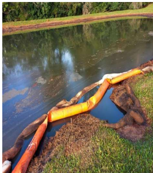
Material residual confinados nas barreiras de contenções
