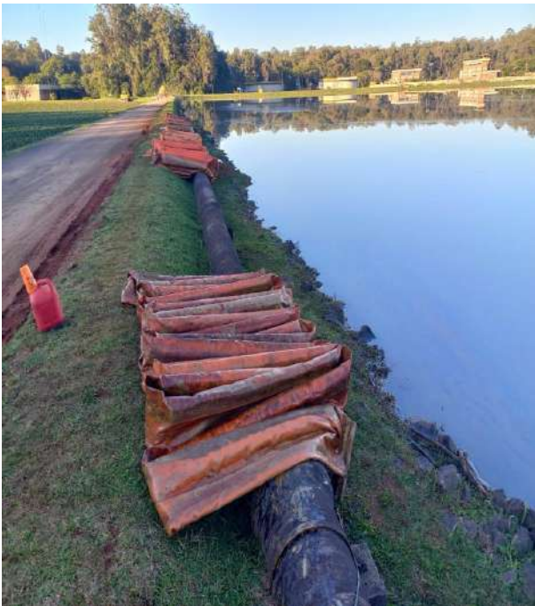
Remoção das barreiras de contenções
