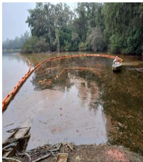
Reposicionamento das barreiras para confinamento do resíduo
