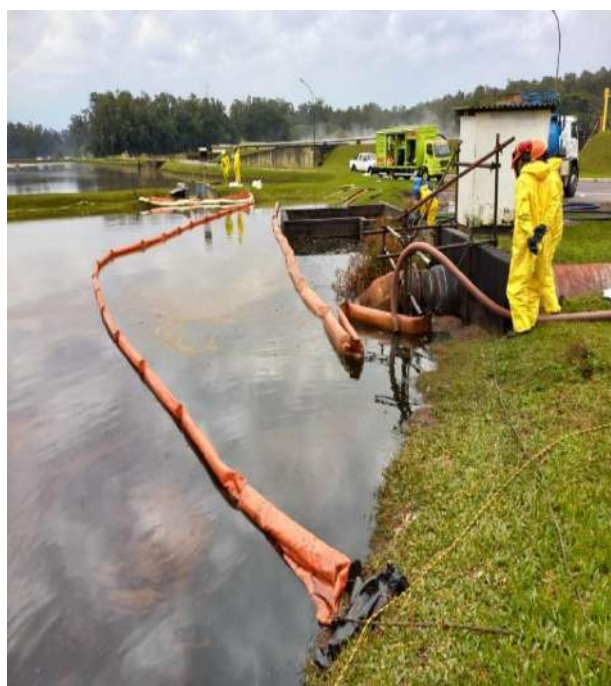
Sucção do material residual
