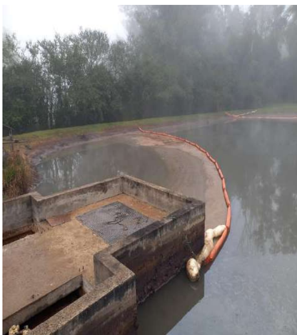
Barreiras absorventes e de contenção posicionadas na lagoa
