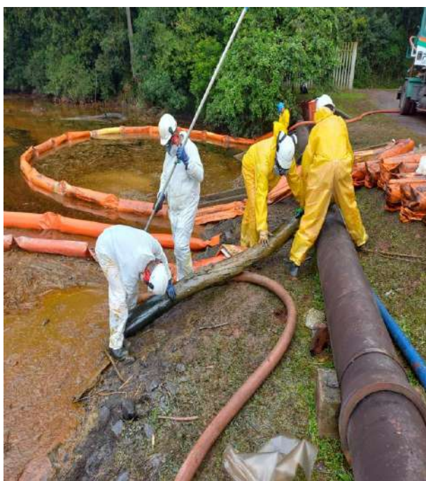
Sucção do material residual
