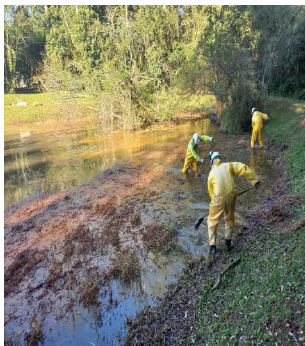
Remoção da vegetação contaminada
