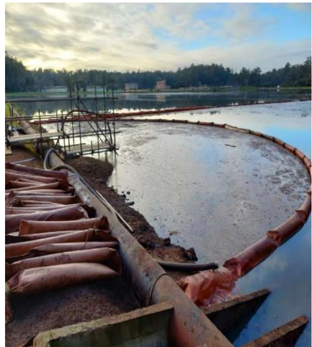
Material residual confinados nas barreiras de contenções
