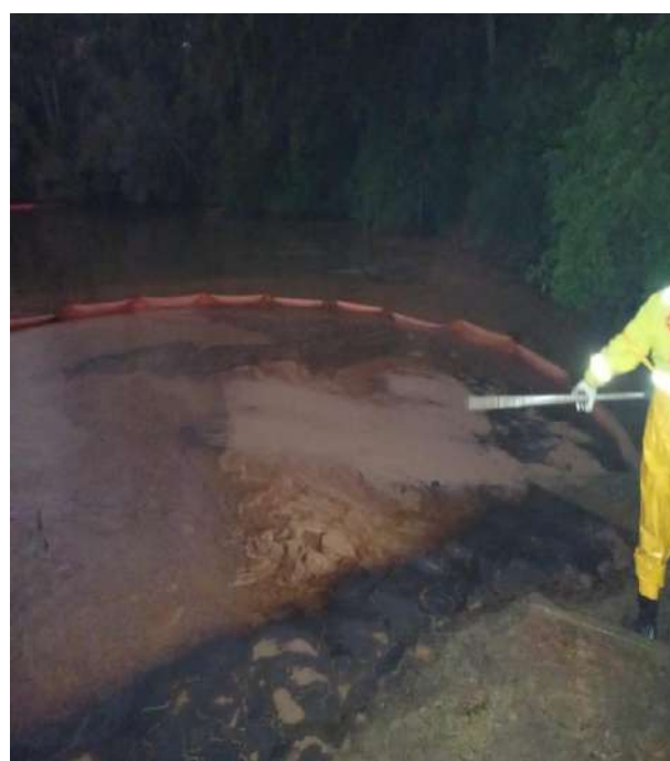
Aplicação de turfa no produto confinado nas barreiras de contenções
