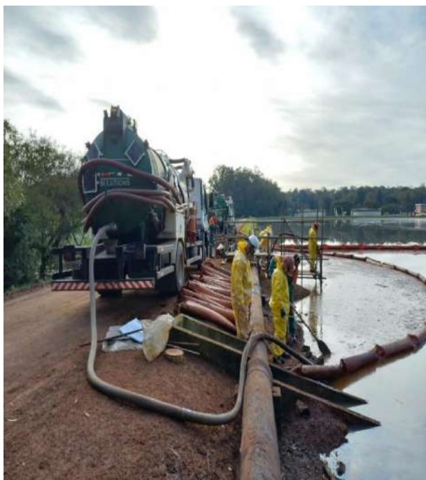
Sucção do material residual
