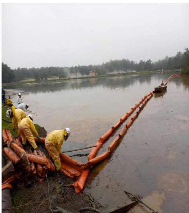
Reposicionamento das barreiras para confinamento do resíduo
