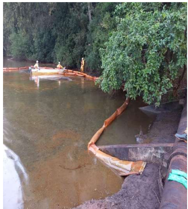
Reposicionamento e arraste das barreiras de contenções
