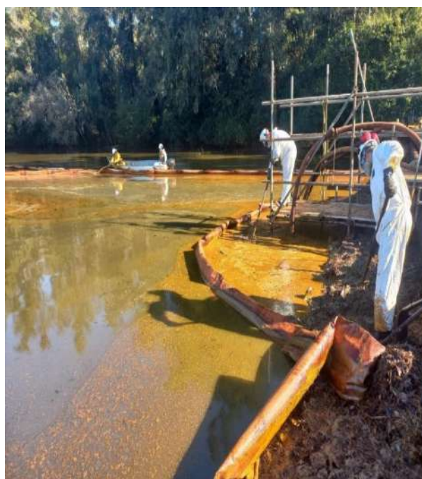
Remoção do material residual sólido
