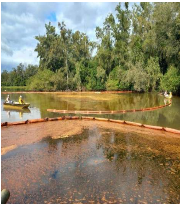
Reposicionamento e arraste das barreiras de contenções
