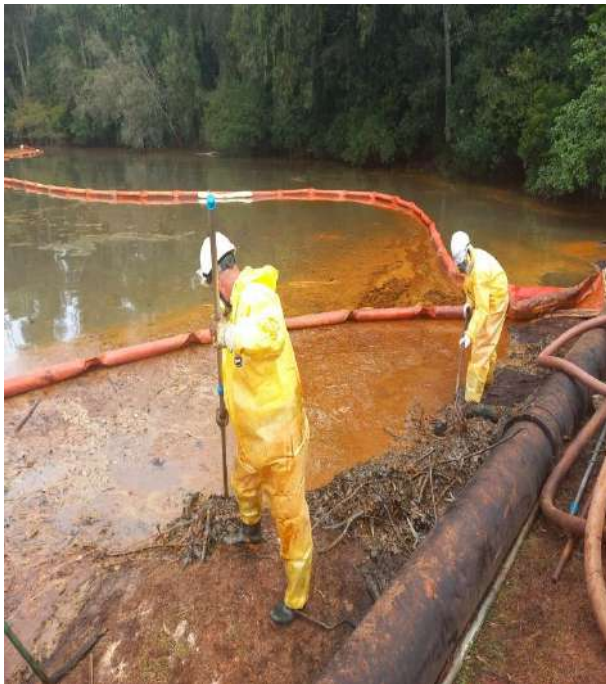
Continuidade na remoção do material residual sólido
