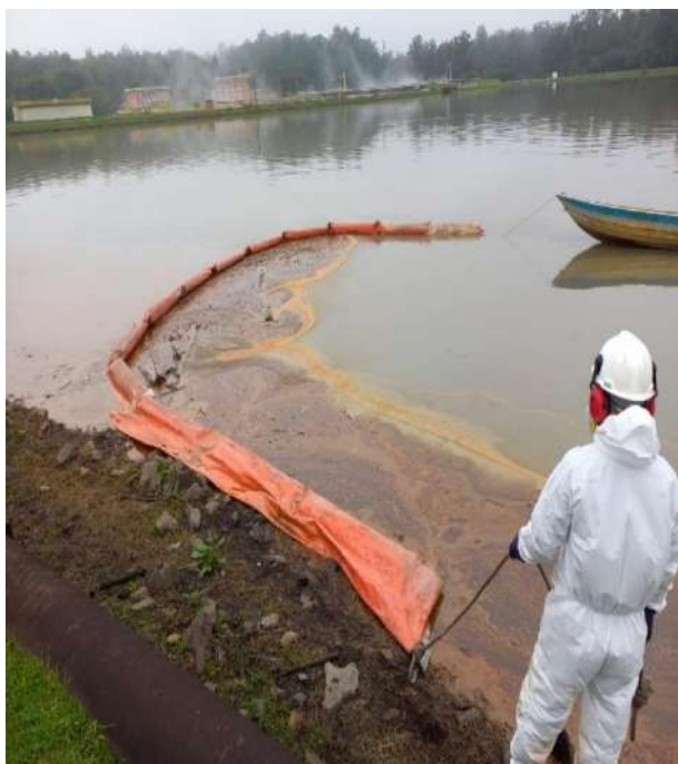
Arraste da barreira de contenção
