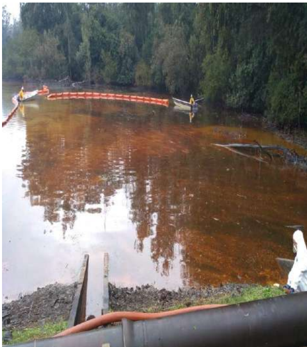
Equipe da GRI realizando o posicionamento das barreiras de contenções
