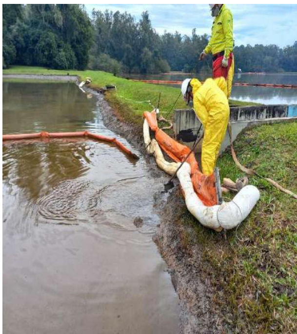
Posicionamento de barreiras absorventes
