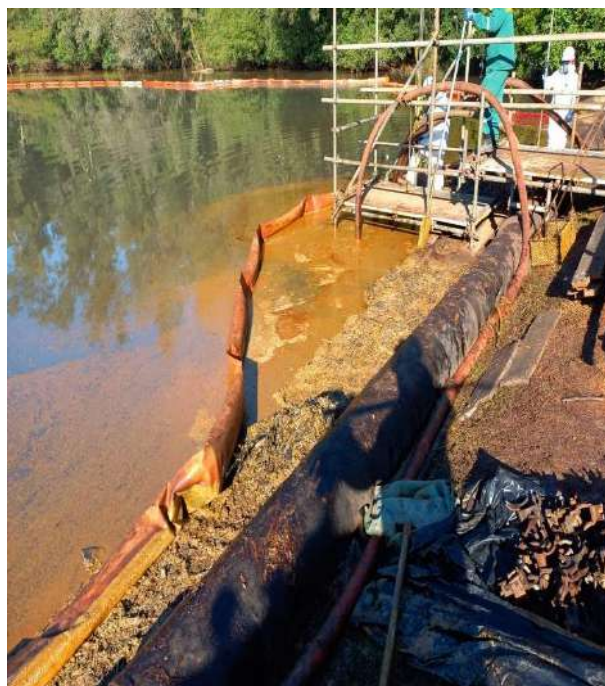
Sucção do material residual
