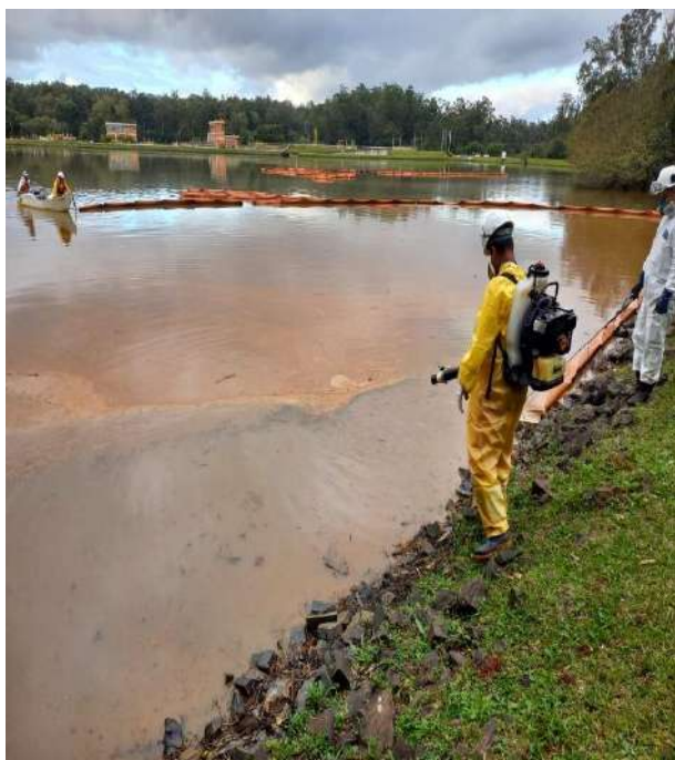
Auxílio nos trabalhos com apoio do soprador mecânico e confinamento do produto
