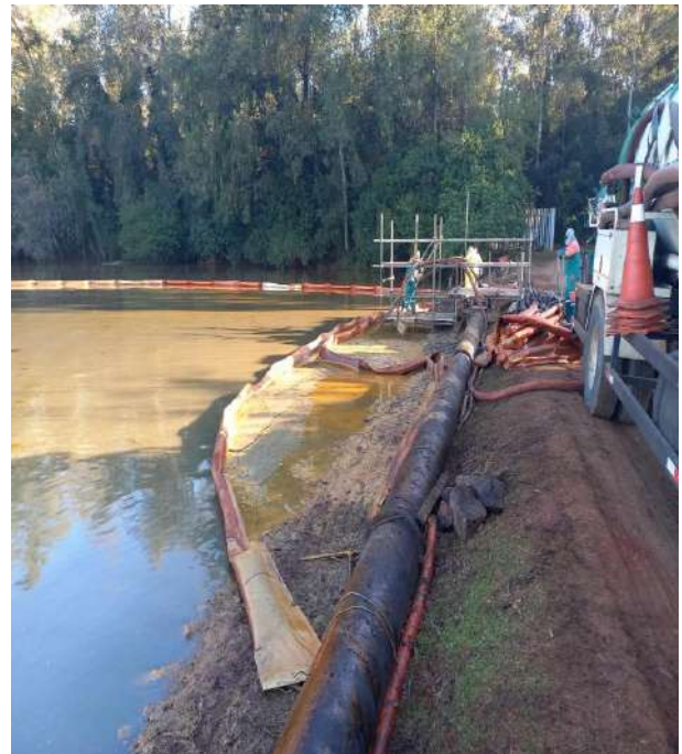
Sucção do material residual
