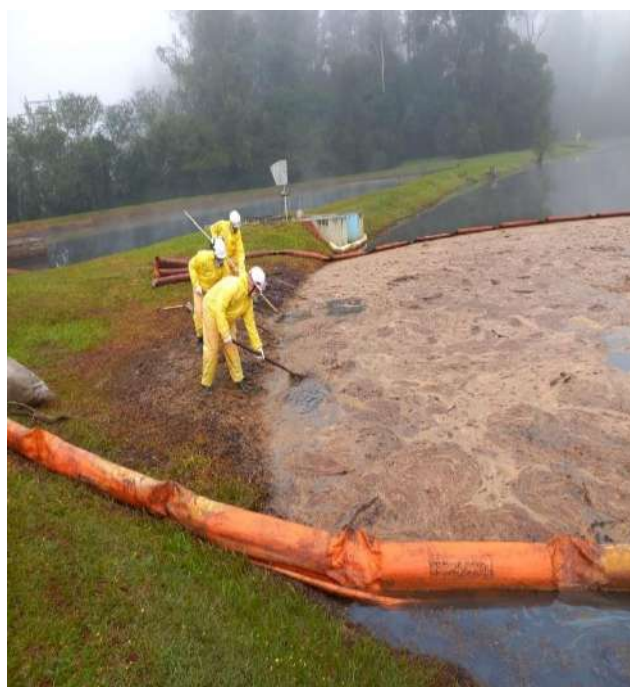
Remoção do material residual sólido
