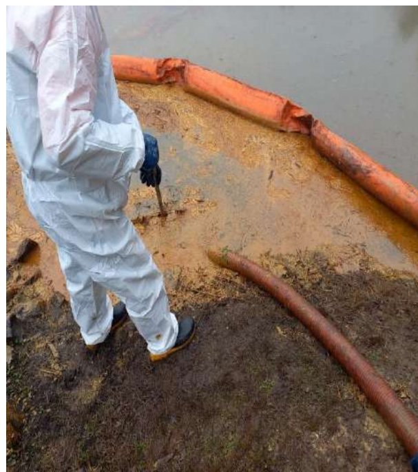
Sucção do material residual líquido
