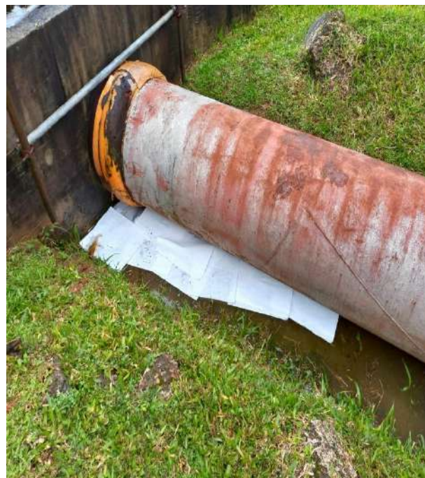
Aplicação de mantas absorventes
