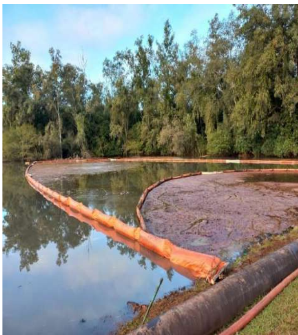
Material residual confinados nas barreiras de contenções
