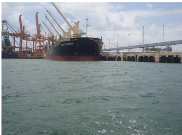
Foto 0.24: Verificação de área junto a navio no cais (25/10/19).
