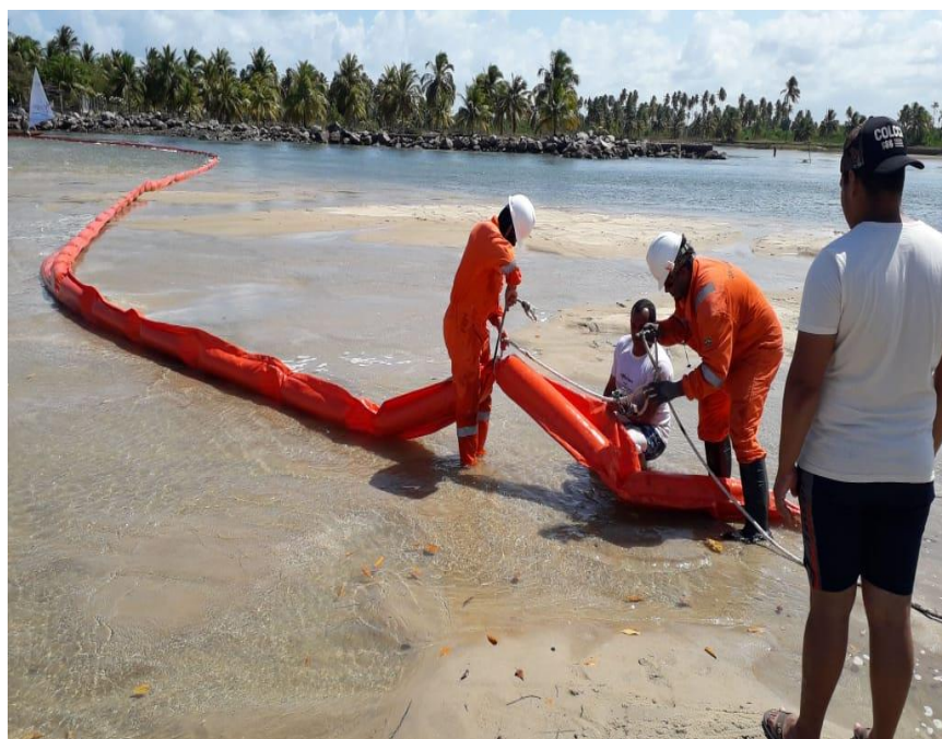
Foto 0.34: Instalação de barreira de contenção na costa (28/10/19).
