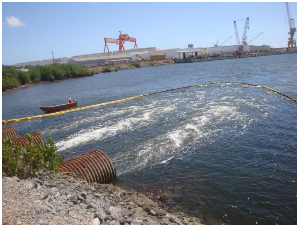
Foto 0.44: Cerco junto à margem (31/10/19).
