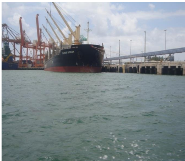
Foto 0.19: Verificação de área junto a navio no cais (23/10/19).
