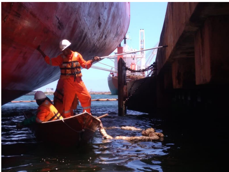
Foto 0.20: Lançamento de barreira de contenção por técnicos da Navemestra (23/10/19).
