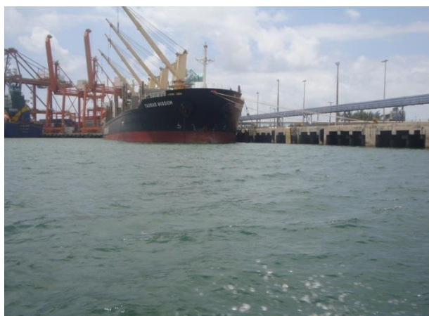
Foto 3.24: Verificação de área junto a navio no cais (25/10/19).
