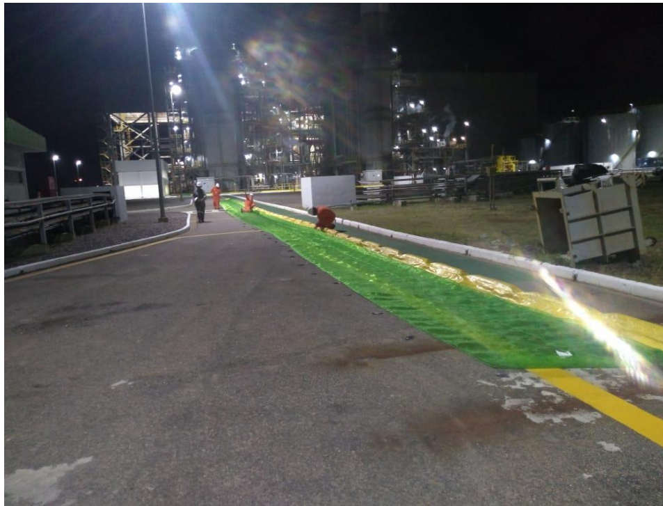
Foto 3.9: Costura da saia na barreira de contenção (21/10/19).
