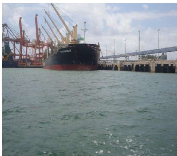
Foto 3.19: Verificação de área junto a navio no cais (23/10/19).
