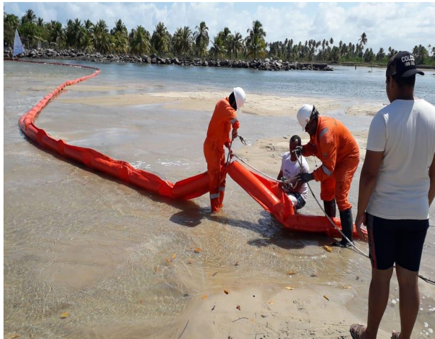
Foto 3.34: Instalação de barreira de contenção na costa (28/10/19).
