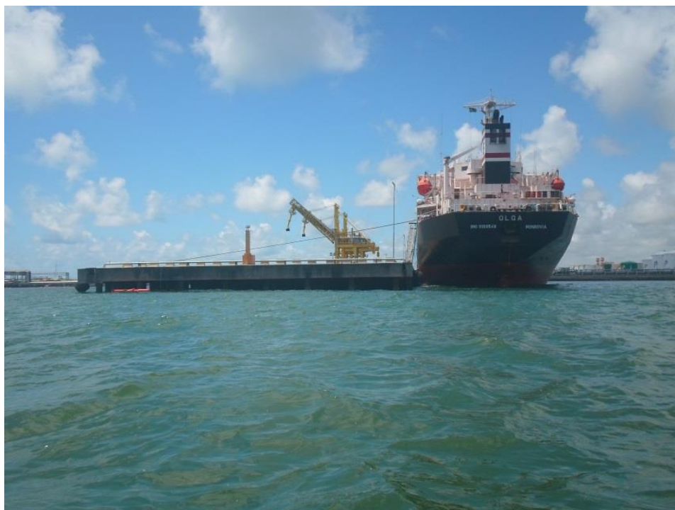
Foto 3.50: Vistoria de mar nas proximidade do cais (03/11/19).
