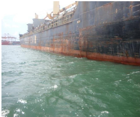
Foto 3.18: Verificação de área junto a navio no cais (23/10/19).
