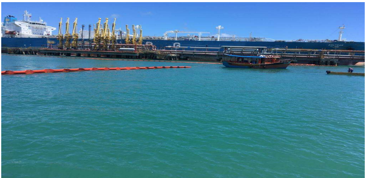
Lançamento de barreira de contenção
