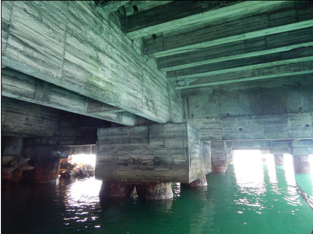
Foto 4 – vista inferior geral do pier.
