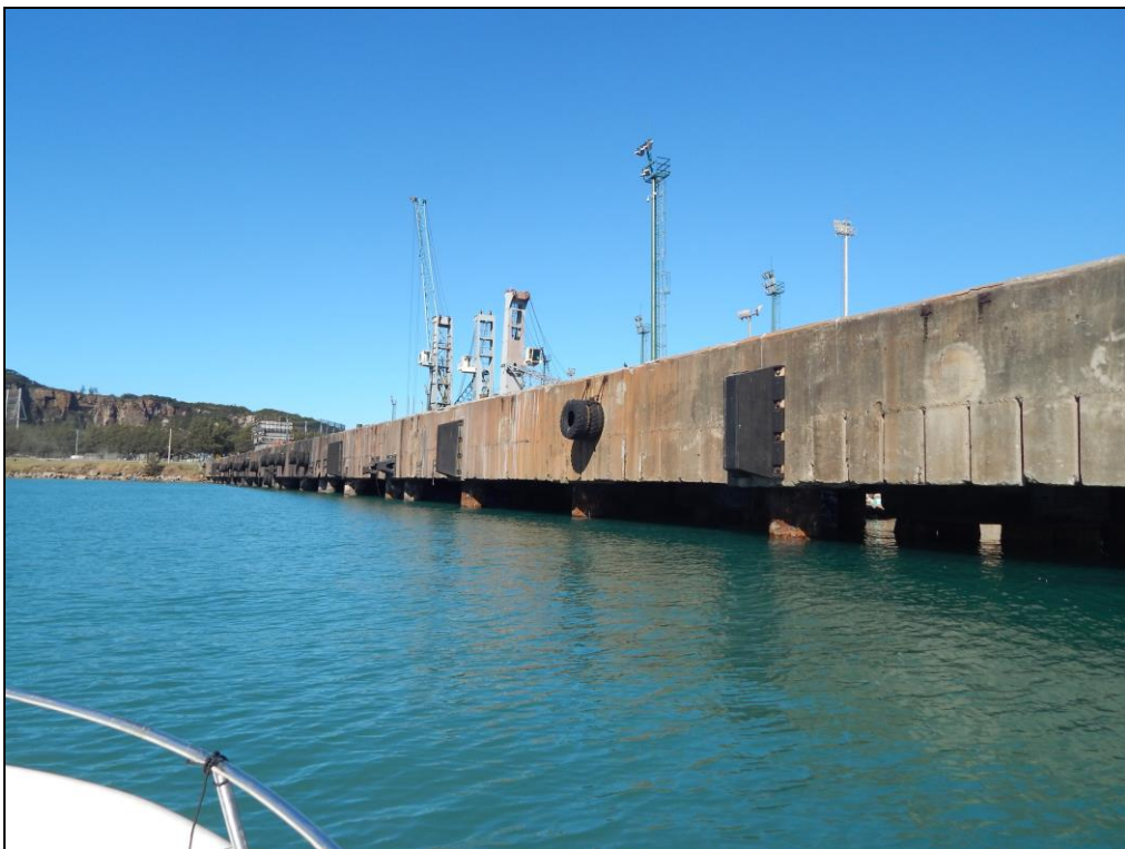
Foto 3 – vista geral da frente de atracação.
