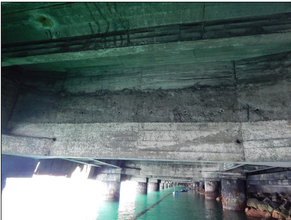
Foto 5 – vista inferior geral do cais.
