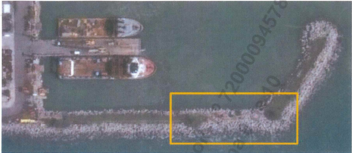
Figura 9: Detalhe da região danificada no quebramar/molhe.
